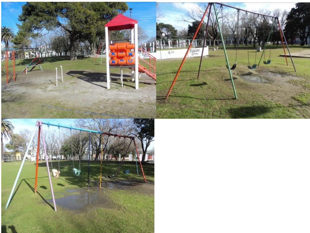
Figura 19: Plaza Irigoyen: se puede observar a la izquierda un dispositivo lúdico integrado en estado Malo por ausencia de puente, barandas y tobogán.
