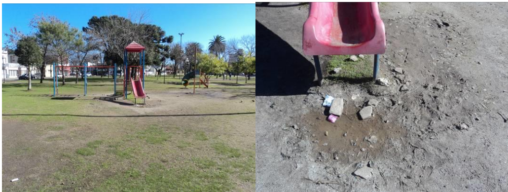
Figura 16: Plaza Azcuénaga. Erosión entre el 30-50%. Ciudad de La Plata. Año 2016.
