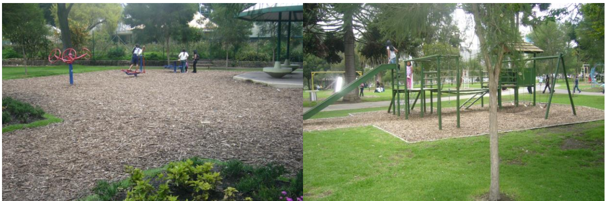
Figura 18: Solado que absorbe impactos y proveniente del chipeado de podas, solado absorbente y orgánico, delimitado por contención perimetral. Quito, Ecuador. Año: 2013.
