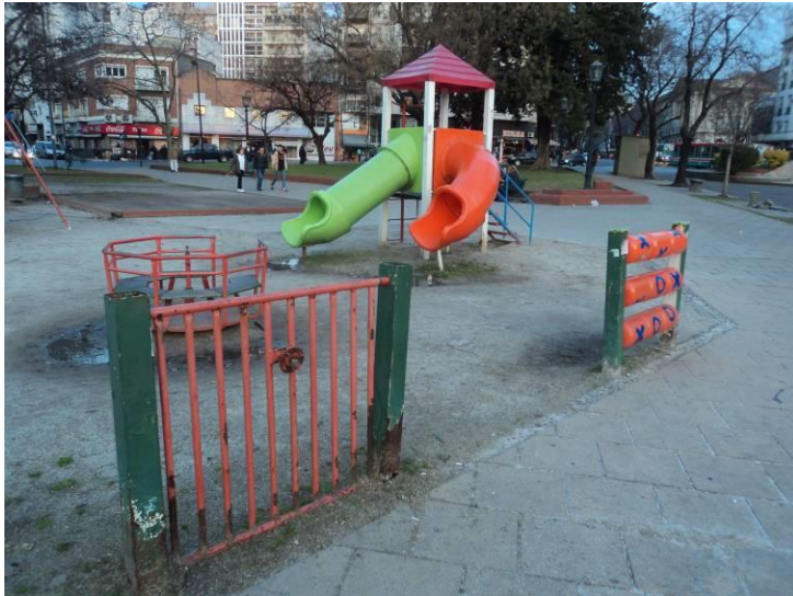
Figura 20: Plaza Italia: se pueden observar dispositivos lúdicos categoría Otro (volante) y Calesita en estado Malo, por ausencia de funcionalidad y presencia de óxido. A su vez, se observa erosión en todo el ámbito con presencia de encharcamientos que dificultan su uso.
