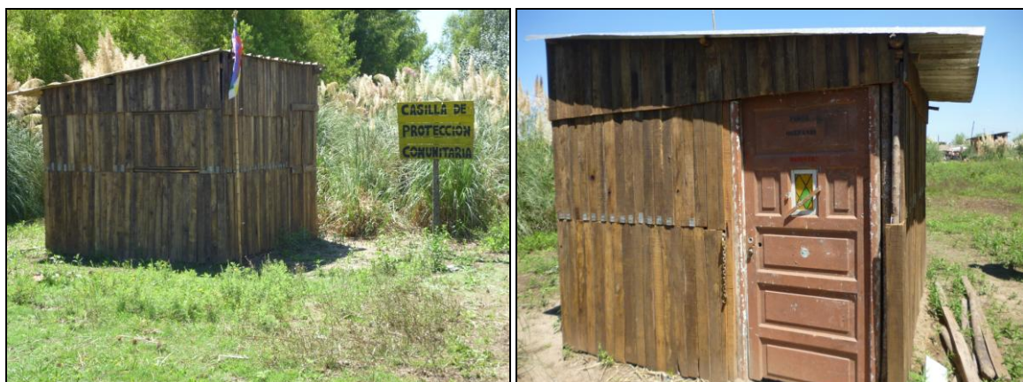
Figura 57: Casilla de protección comunitaria Fuente: Vallejo, febrero 2017
