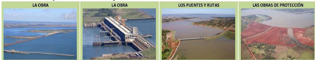
Fotos N° 33 a 36: Conjunto de Construcciones que define el sentido de la ‘transformación’
