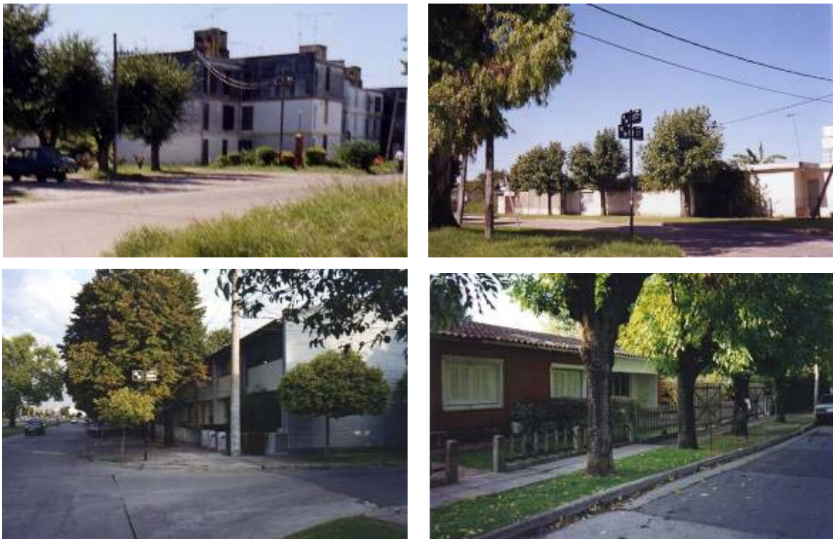
Fig. 51: Diverso desarrollos habitacionales en el Barrio de Tolosa – La Plata.
