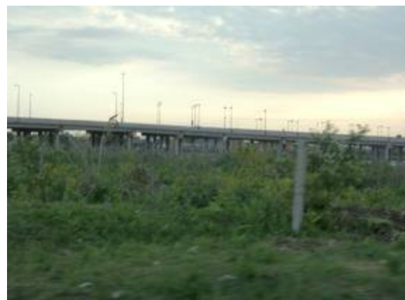
Fig. 92: Subida Autopista Buenos Aires-La Plata
