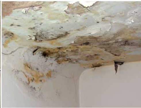
Fig. 23_Det. de cielorraso de oficina en entrepiso Fuente: fotografía tomada por la autora
