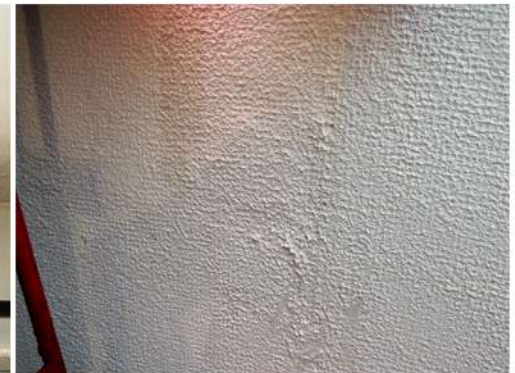
Fig. 20_Det. antepecho en estar-comedor Fuente: fotografía tomada por la autora
