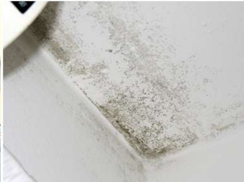
Fig. 26_Cielorraso de dormit. ppal. Fuente: fotografía tomada por la autora
