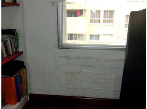
Fig. 8_Abertura hacia calle L. Carnelli. Fuente: imagen tomada por la autora
