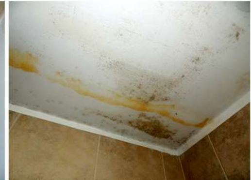
Fig. 26_Cielorraso de baño Fuente: fotografía tomada por la autora
