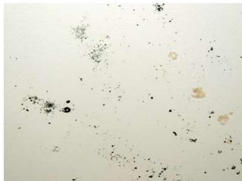
Fig. 36_Det. de cielorraso de baño (M2) Fuente: fotografía tomada por la autora
