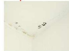
Muestra M2 cielorraso del baño
