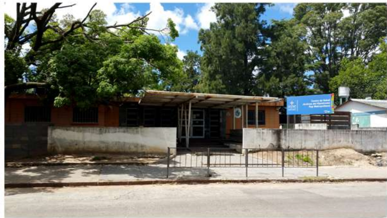
Fig 2_ Vista de la fachada principal del edificio en estudio Fuente: Fotografía tomada por la autora
