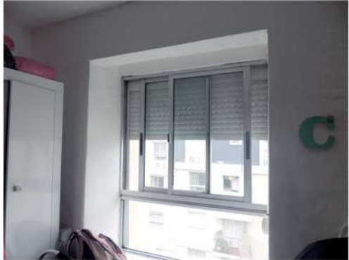
Fig. 8_Imagen parcial del dormit. sec. Fuente: imagen tomada por la autora
