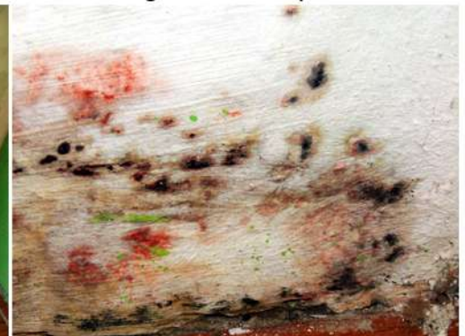
Fig. 22_Det. mohos en dormit. sec. Fuente: fotografía tomada por la autora
