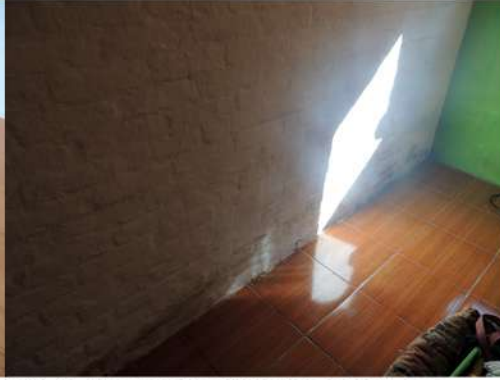
Fig. 6_Imagen parcial del dormit. sec. Fuente: imagen tomada por la autora
