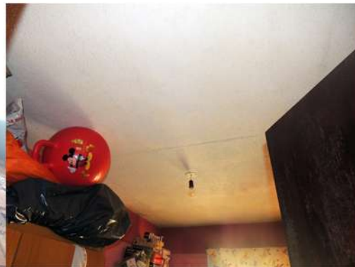
Fig. 7_Imagen parcial del dormit. sec. Fuente: imagen tomada por la autora
