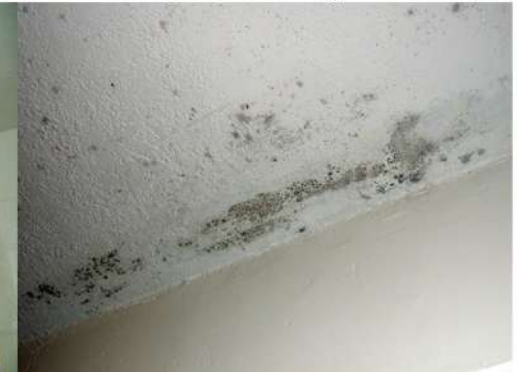
Fig. 27_Det. cielorraso dormit. ppal. Fuente: fotografía tomada por la autora
