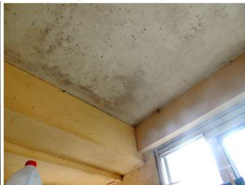
Fig. 26_Cielorraso de lavadero Fuente: fotografía tomada por la autora
