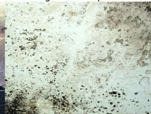
Fig. 28_Det. de cielorraso de cocina Fuente: fotografía tomada por la autora
