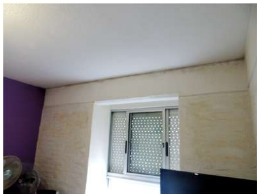
Fig. 5_Imagen parcial del dormit. sec. Fuente: imagen tomada por la autora
