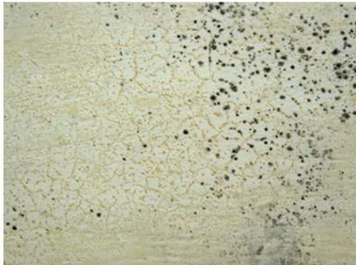
Fig. 22_Det. de cielorraso de dormit. sec. Fuente: fotografía tomada por la autora
