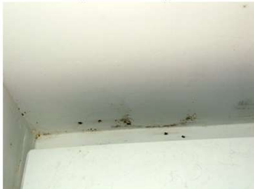
Fig. 25_Cielorraso del sobre AA Fuente: fotografía tomada por la autora
