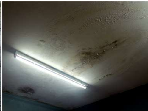
Fig. 25_Cielorraso de cocina Fuente: fotografía tomada por la autora
