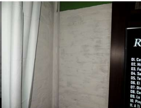
Fig. 19_Det. pared exterior enmohecida Fuente: fotografía tomada por la autora
