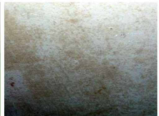
Fig. 30_Det. del cielorraso del dormit. ppal. (M1) Fuente: fotografía tomada por la autora
