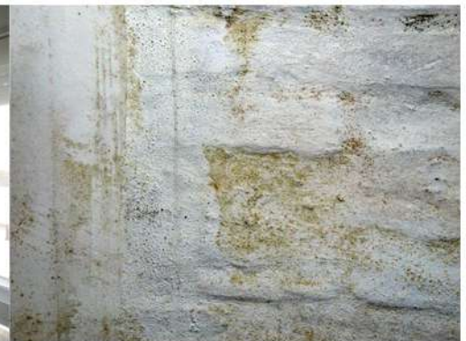
Fig. 35_Detalle de antepecho de fachada principal (M3) Fuente: fotografía tomada por la autora
