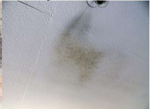
Fig. 26_Det. cielorraso de baño Fuente: fotografía tomada por la autora
