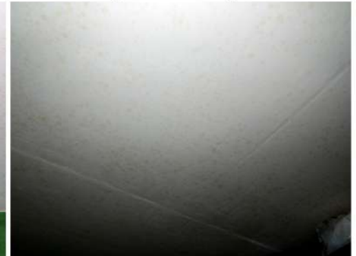
Fig. 23_Det. mohos en cielorraso dormi. ppal. Fuente: fotografía tomada por la autora
