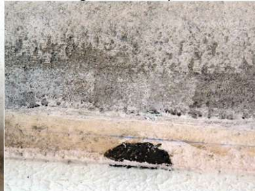
Fig. 25_Det. mohos cielorraso estar-com. Fuente: fotografía tomada por la autora
