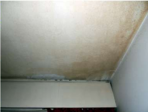
Fig. 25_Cielorraso de dormit. ppal. Fuente: fotografía tomada por la autora
