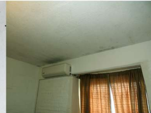
Fig. 26_Cielorraso del dormit. ppal. Fuente: fotografía tomada por la autora
