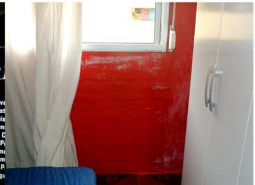
Fig. 20_Mohos en antepecho dorm. sec. Fuente: fotografía tomada por la autora
