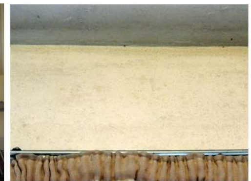
Fig. 29_Det. del dintel del estar-comedor (M1) Fuente: fotografía tomada por la autora
