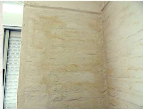
Fig. 20_Det. de mohos en pared ext. Fuente: fotografía tomada por la autora
