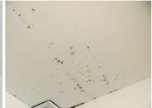
Fig. 27_Cielorraso de baño Fuente: fotografía tomada por la autora
