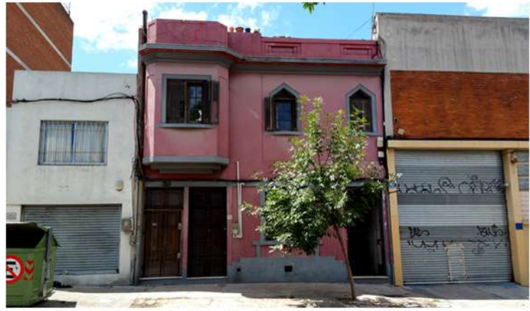
Fig 2_ Vista de la fachada principal de la vivienda Fuente: Fotografía tomada por la autora
