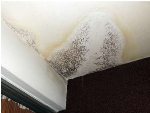
Fig. 21_Cielorraso de terraza cerrada Fuente: fotografía tomada por la autora
