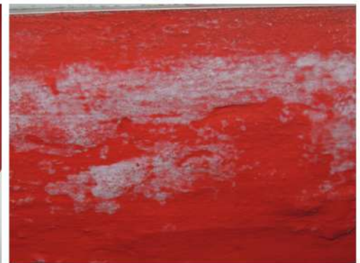
Fig. 27_Det. de antepecho de abertura en dormit. sec. (M2) Fuente: fotografía tomada por la autora
