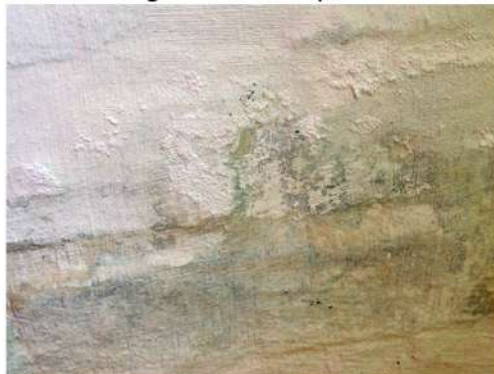
Fig. 23_Det. mohos en dormit. sec. Fuente: fotografía tomada por la autora
