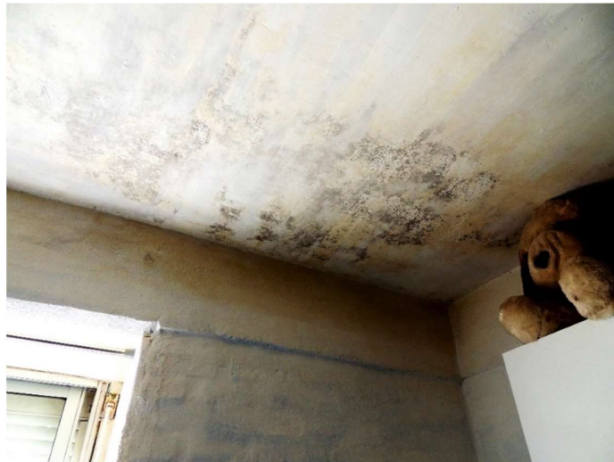
Figura 18: Humedad de condensación en unidad de vivienda de cooperativa COVIREUS AL SUR
