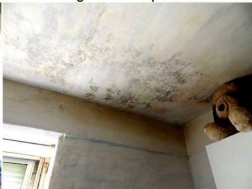
Fig. 9_Imagen parcial del dormit. sec. Fuente: imagen tomada por la autora
