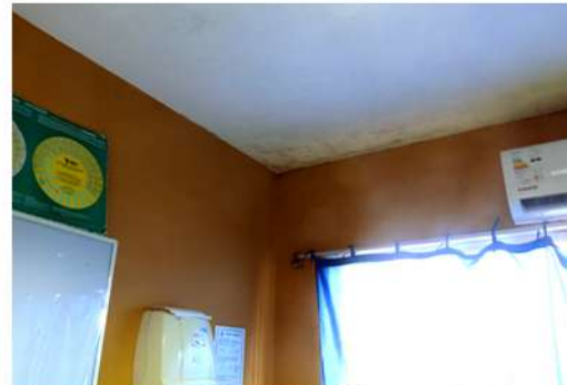
Fig. 7_Imagen parcial del consultorio Fuente: imagen tomada por la autora
