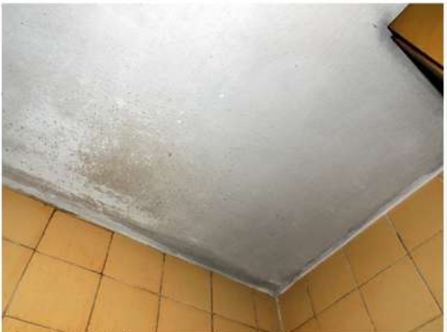
Fig. 24_Cielorraso de cocina Fuente: fotografía tomada por la autora
