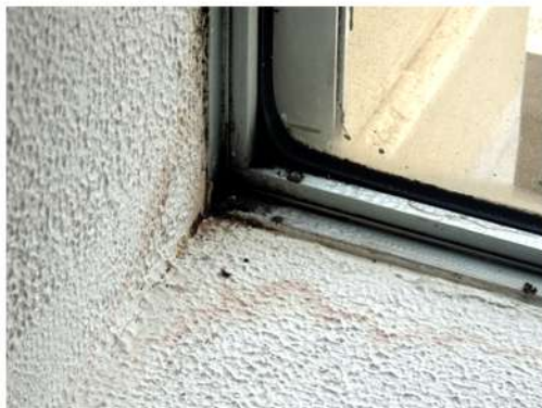
Fig. 19_Det. mohos en mocheta Fuente: fotografía tomada por la autora
