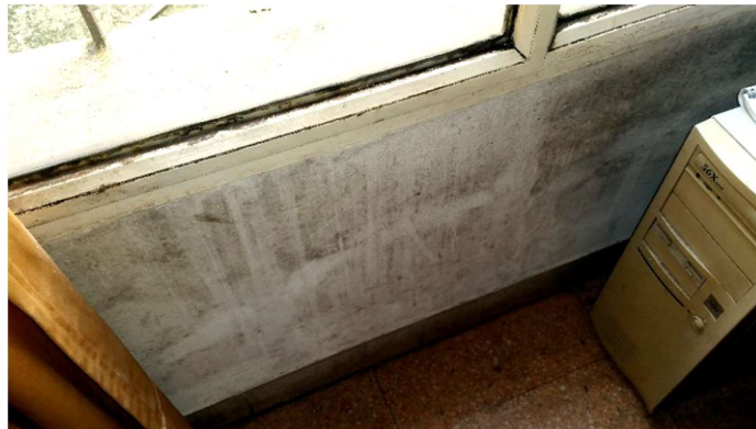
Figura 44: Mohos en antepecho de pared orientación sur. Vivienda en Montevideo.
