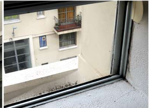
Fig. 21_Det. mohos en mocheta dorm. sec. Fuente: fotografía tomada por la autora
