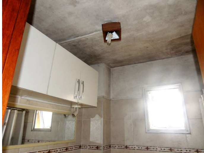
Figura 19: Humedad de condensación en unidad de vivienda de cooperativa COVIREUS AL SUR
