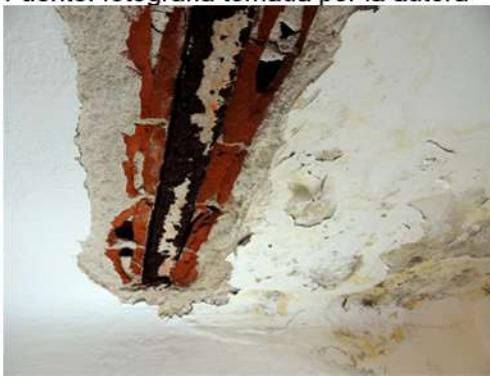
Fig. 26_Cielorraso de oficina en entrepiso Fuente: fotografía tomada por la autora
