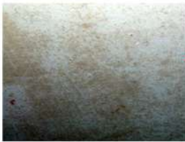
Muestra M1 cielorraso del dormit. ppal.
