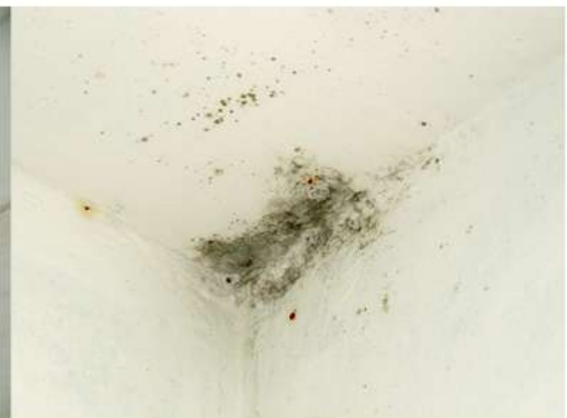
Fig. 21_Det. mohos en triedro dorm. ppal. Fuente: fotografía tomada por la autora
