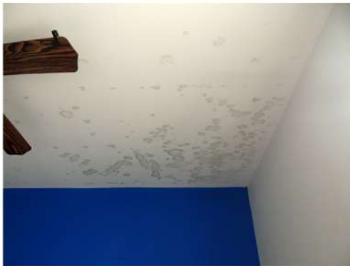
Fig. 16_Cielorraso del dormit. ppal. Fuente: fotografía tomada por la autora
