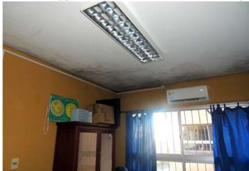
Fig. 5_Imagen parcial del consultorio Fuente: imagen tomada por la autora
