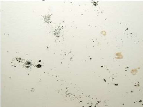
Fig. 28_Detalle cielorraso baño Fuente: fotografía tomada por la autora
