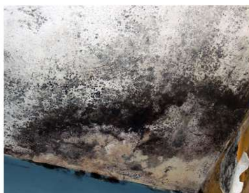
Fig. 36_Detalle de cielorraso de consultorio (M2) Fuente: fotografía tomada por la autora
