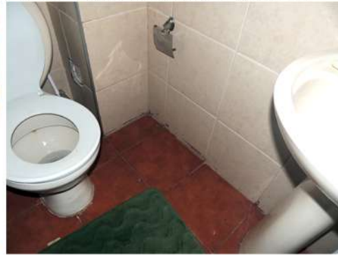
Fig. 9_Imagen parcial del baño Fuente: imagen tomada por la autora
