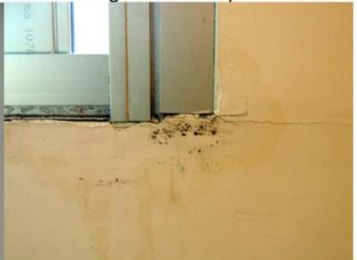
Fig. 26_Det. mohos en carpint. de abertura Fuente: fotografía tomada por la autora
