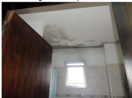
Fig. 8_Imagen parcial del baño. Fuente: imagen tomada por la autora
