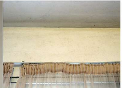
Fig. 19_Det. mohos en dintel del estar Fuente: fotografía tomada por la autora
