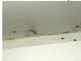
Muestra M1 cielorraso del dormit. ppal.
