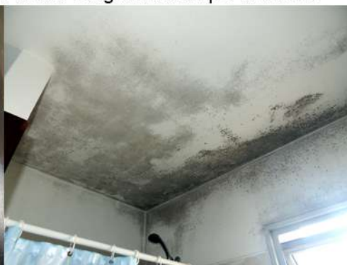
Fig. 9_Imagen parcial del baño Fuente: imagen tomada por la autora
