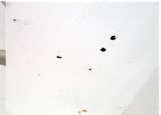
Fig. 27_Det. mohos en baño Fuente: fotografía tomada por la autora
