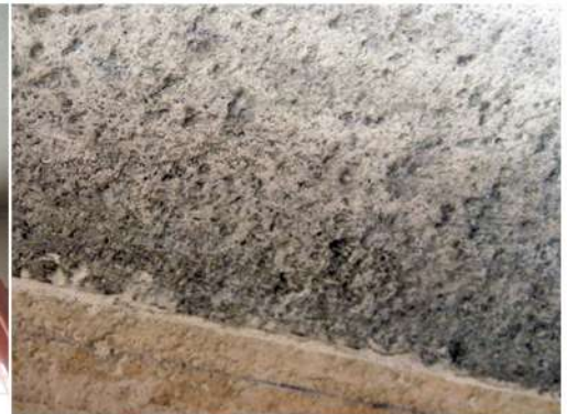
Fig. 30_Det. de cielorraso de estar-comedor (M1) Fuente: fotografía tomada por la autora
