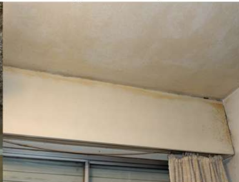
Fig. 28_Cielorraso de dormit. sec Fuente: fotografía tomada por la autora
