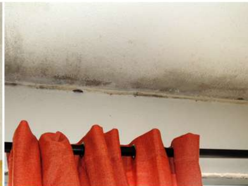
Fig. 19_Det. dintel en estar-comedor Fuente: fotografía tomada por la autora
