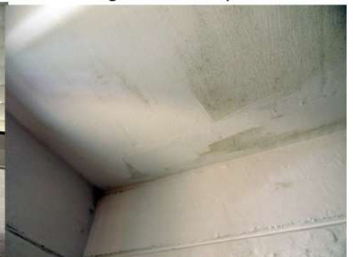
Fig. 26_Det. cielorraso de baño Fuente: fotografía tomada por la autora
