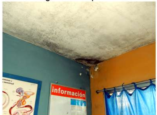
Fig. 8_Imagen parcial del consultorio Fuente: imagen tomada por la autora
