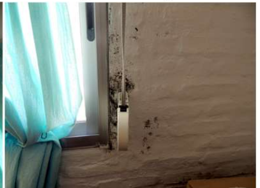
Fig. 23_Det. mohos en cortina de enrollar Fuente: fotografía tomada por la autora
