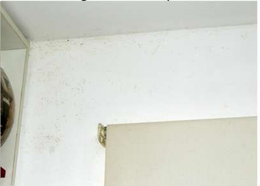
Fig. 30_Cielorraso de estar-comedor Fuente: fotografía tomada por la autora
