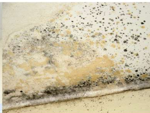
Fig. 23_Det. de mohos en cielorraso PA Fuente: fotografía tomada por la autora
