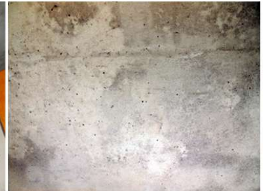
Fig. 24_Detalle de cielorraso del lavadero Fuente: fotografía tomada por la autora
