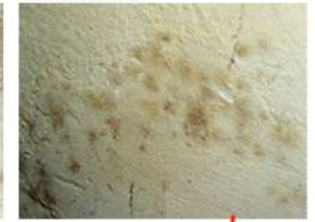
Muestra M6 pared oficina en PA a nivel de zócalo
