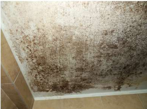
Fig. 27_Cielorraso de baño Fuente: fotografía tomada por la autora
