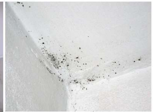
Fig. 26_Det. de cielorraso del baño (M2) Fuente: fotografía tomada por la autora
