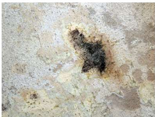
Fig. 36_Detalle de cielorraso de sala de reuniones (M8) Fuente: fotografía tomada por la autora
