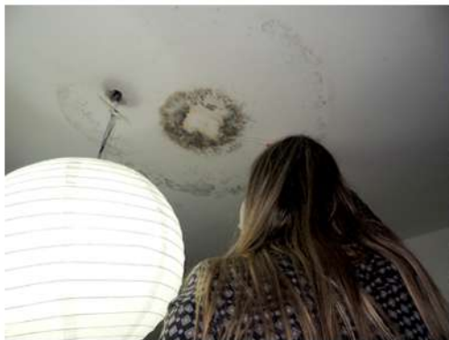
Fig. 30_Toma de muestra con hisopo estéril en cielorraso estar-comedor (M1) Fuente: imagen propia de la autora
