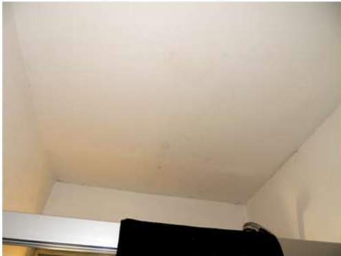
Fig. 20_Det. cielorraso de baño Fuente: fotografía tomada por la autora
