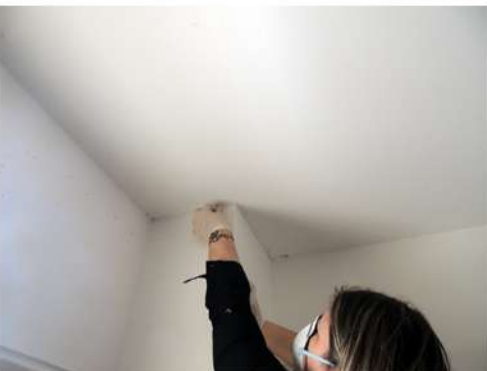
Fig. 29_Toma de muestra con cinta en cielorraso del baño (M2) Fuente: imagen propia de la autora
