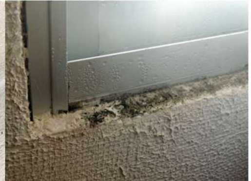
Fig. 23_Det. mohos y marco condensado Fuente: fotografía tomada por la autora
