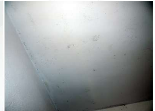
Fig. 22_Det. cielorraso de baño Fuente: fotografía tomada por la autora
