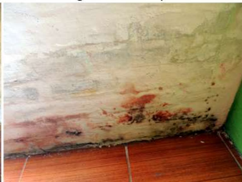
Fig. 21_Det. mohos en dormit. sec. Fuente: fotografía tomada por la autora
