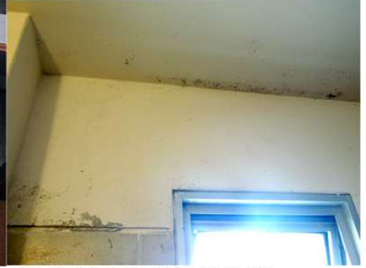
Fig. 7_Imagen parcial del baño Fuente: imagen tomada por la autora
