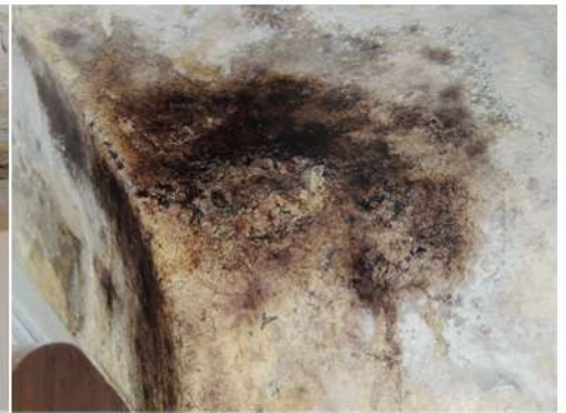
Fig. 24_Detalle de triedro en oficina de PA Fuente: fotografía tomada por la autora
