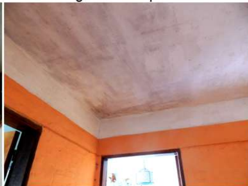
Fig. 10_Imagen parcial del corredor en PA Fuente: imagen tomada por la autora
