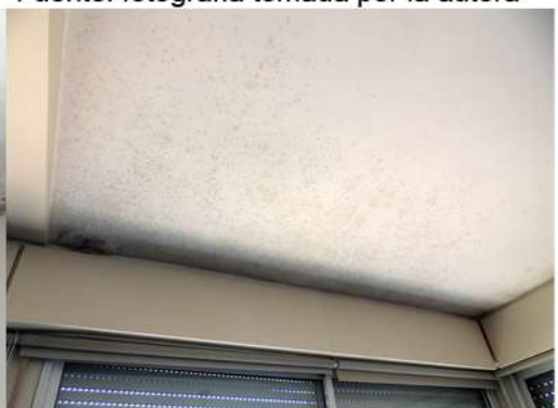
Fig. 30_Cielorraso de estar-comedor Fuente: fotografía tomada por la autora
