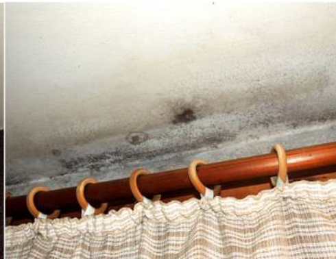
Fig. 22_Dintel de abertura en terraza Fuente: fotografía tomada por la autora
