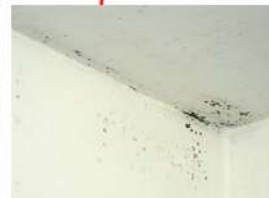
Muestra M2 cielorraso del baño ppal.
