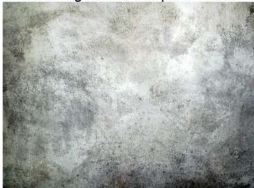
Fig. 24_Det. de cielorraso del consultorio Fuente: fotografía tomada por la autora
