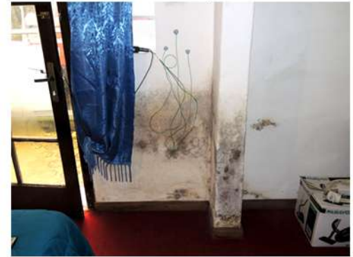
Fig. 10_Pared del dormitorio principal Fuente: imagen tomada por la autora
