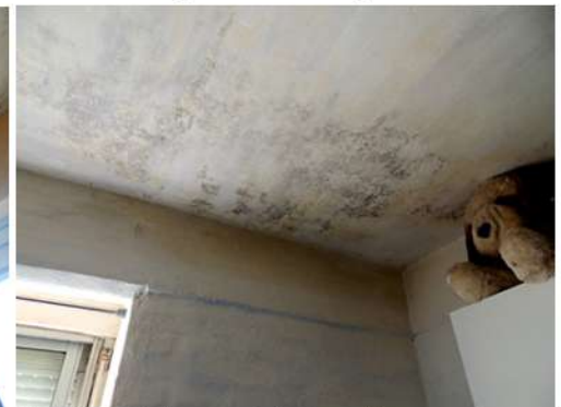
Fig. 27_Cielorraso de dormit. sec. Fuente: fotografía tomada por la autora
