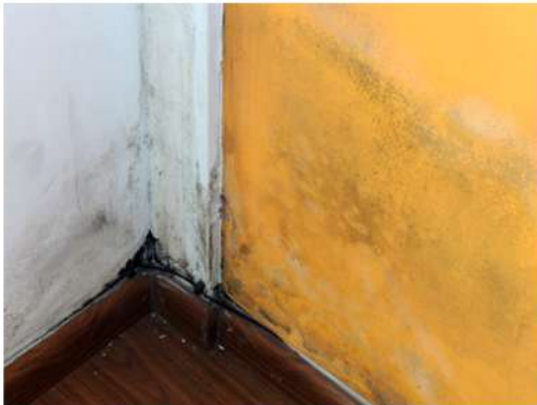
Fig. 18_Det. mohos en triedro inferior Fuente: fotografía tomada por la autora
