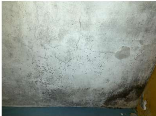
Fig. 21_Det. de cielorraso del consultorio evaluado Fuente: fotografía tomada por la autora
