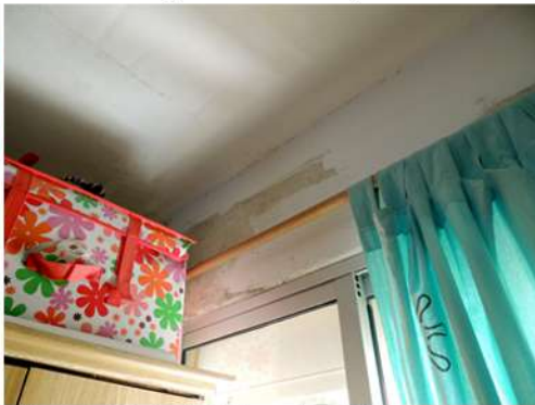
Fig. 22_Det. dintel en dormit. sec. Fuente: fotografía tomada por la autora
