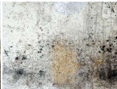
Fig. 36_Detalle de mohos en pared del baño (M13) Fuente: fotografía tomada por la autora
