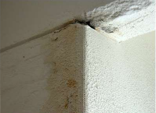
Fig. 27_Det. mocheta abertura dormit. ppal. Fuente: fotografía tomada por la autora
