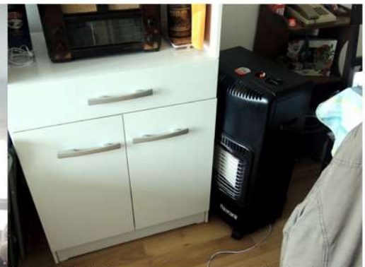
Fig. 7_Estufa a supergas en planta baja Fuente: imagen tomada por la autora
