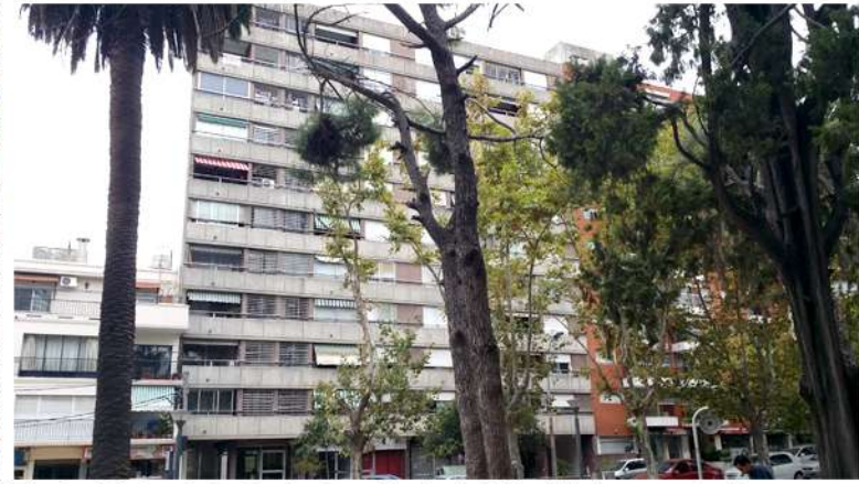
Fig 2_ Vista de la fachada principal del edificio en estudio Fuente: Fotografía tomada por la autora
