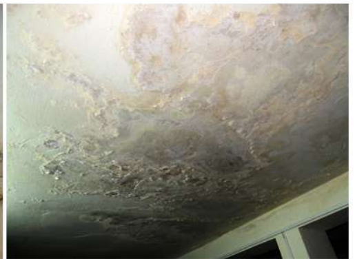
Fig. 27_Det. de cielorraso de oficina en PA Fuente: fotografía tomada por la autora
