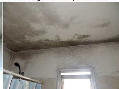
Fig. 10_Imagen parcial del baño Fuente: imagen tomada por la autora
