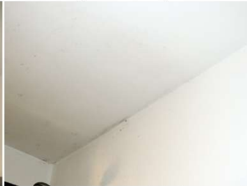
Fig. 21_Det. cielorraso de baño Fuente: fotografía tomada por la autora
