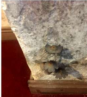
Fig. 27_Setas creciendo en zócalo de dormitorio principal Fuente: fotografía tomada por la autora
