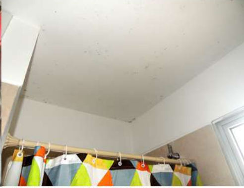
Fig. 6_Imagen parcial del baño Fuente: imagen tomada por la autora
