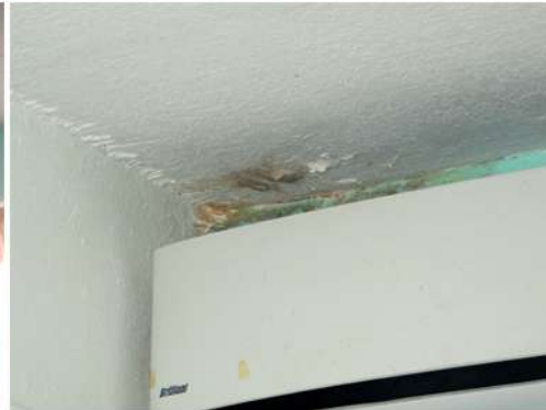
Fig. 20_Det. cielorraso sobre AA Fuente: fotografía tomada por la autora
