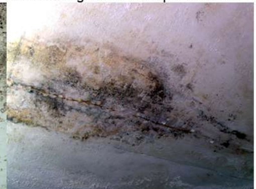
Fig. 29_Det. de cielorraso de cocina Fuente: fotografía tomada por la autora
