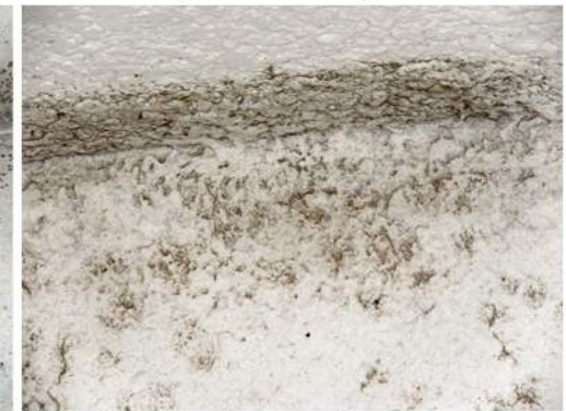
Fig. 24_Det. mohos en dorm. sec. Fuente: fotografía tomada por la autora
