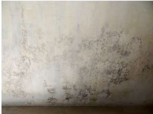
Fig. 25_Cielorraso de dormit. sec. Fuente: fotografía tomada por la autora
