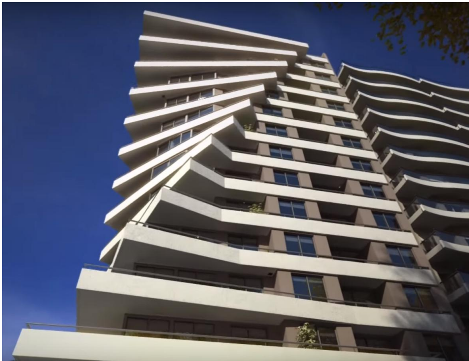
Figura 15: Edificio Nautilo en construcción - Rosario, Santa Fé. Arq. Enrique Aronson y Marcelo Gonano. Fuente: sitio web de Edificio Nautilo.
