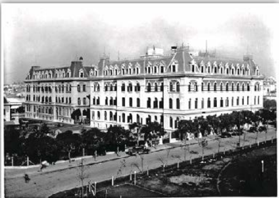
Fig. N° 25 y 26.- Fotografía frontal del conjunto edilicio desde la actual Avenida Paseo Colón y Vista desde calle Estados Unidos, esquina Azopardo. circa 1938 (Digitalizadas por el CeDIAP).
