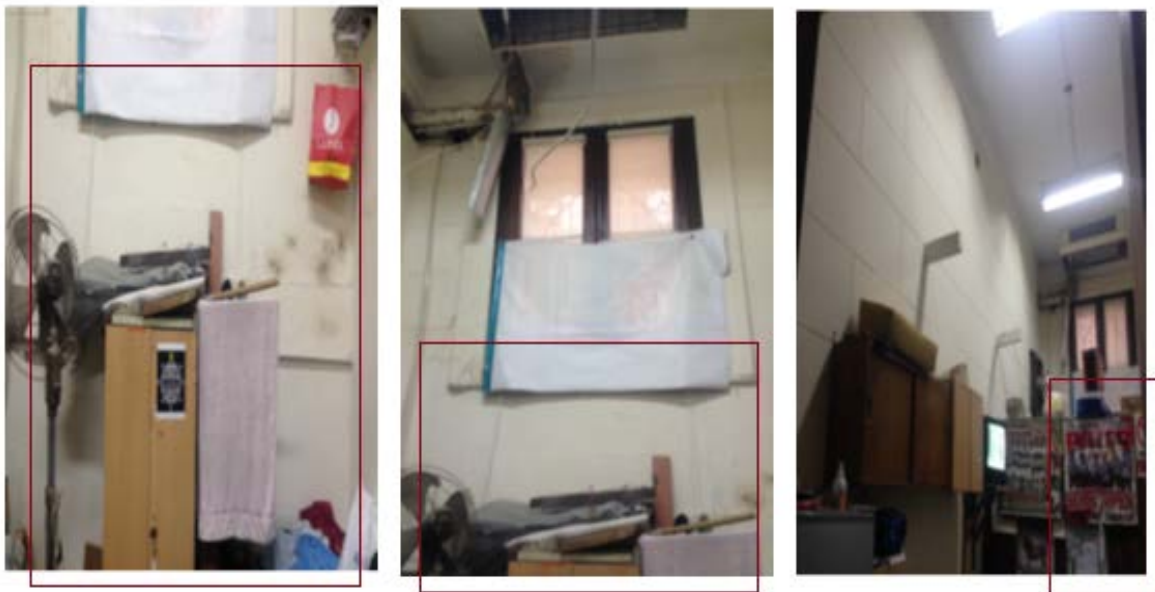
Fig. N° 29 a 31.- Imágenes actuales Pañol oficina N° 55 edificio Paseo Colón 922 Subsuelo (Autoría Propia).
