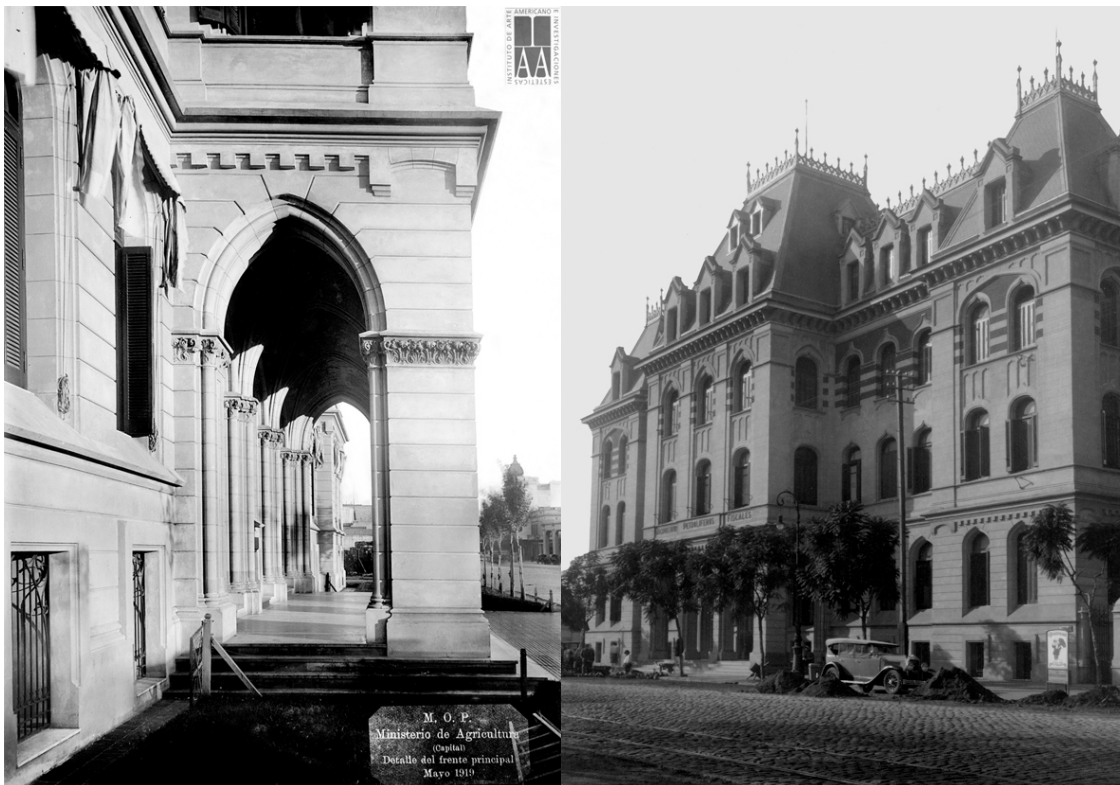
Fig. Nº 31 a 33.- IMÁGENES CONJUNTO EDIFICIO Y DETALLE FRENTE PRINCIPALES
