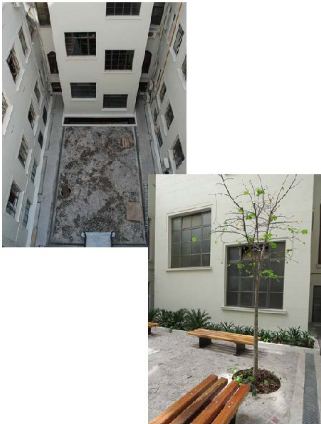
Fig. N° 57 y N° 58.- Imágenes de la intervención edilicia en el patio interno del Edificio de Paseo Colón N° 922, durante la ejecución de los trabajos y resultado final. (Autoría: arquitecto Marcelo Magadán- Año 2013).
