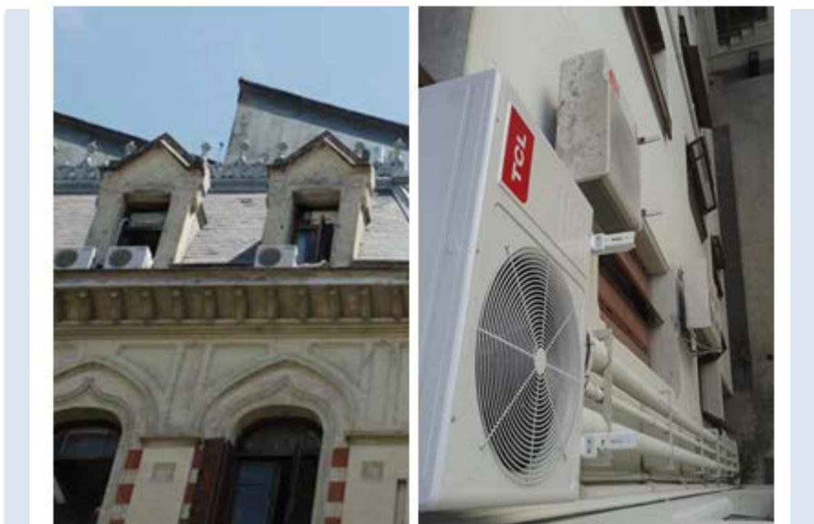
Fig. N° 53 y 54.- Imágenes fachada posterior (cara este) Edificio Paseo Colon N° 982 previo a las obras de readecuación y fachada interna una vez intervenida. (Autoría: Marta Casabene fotógrafa del Programa de Patrimonio Cultural del Ministerio de Agroindustria).
