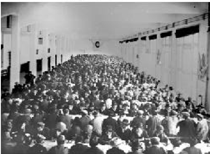
Fig. Nº 20 a 22- Imágenes de la fachada principal del edificio, el parque y el desembarcadero, dormitorios y comedores - "Hotel de los Inmigrantes"- Buenos Aires, Argentina.
