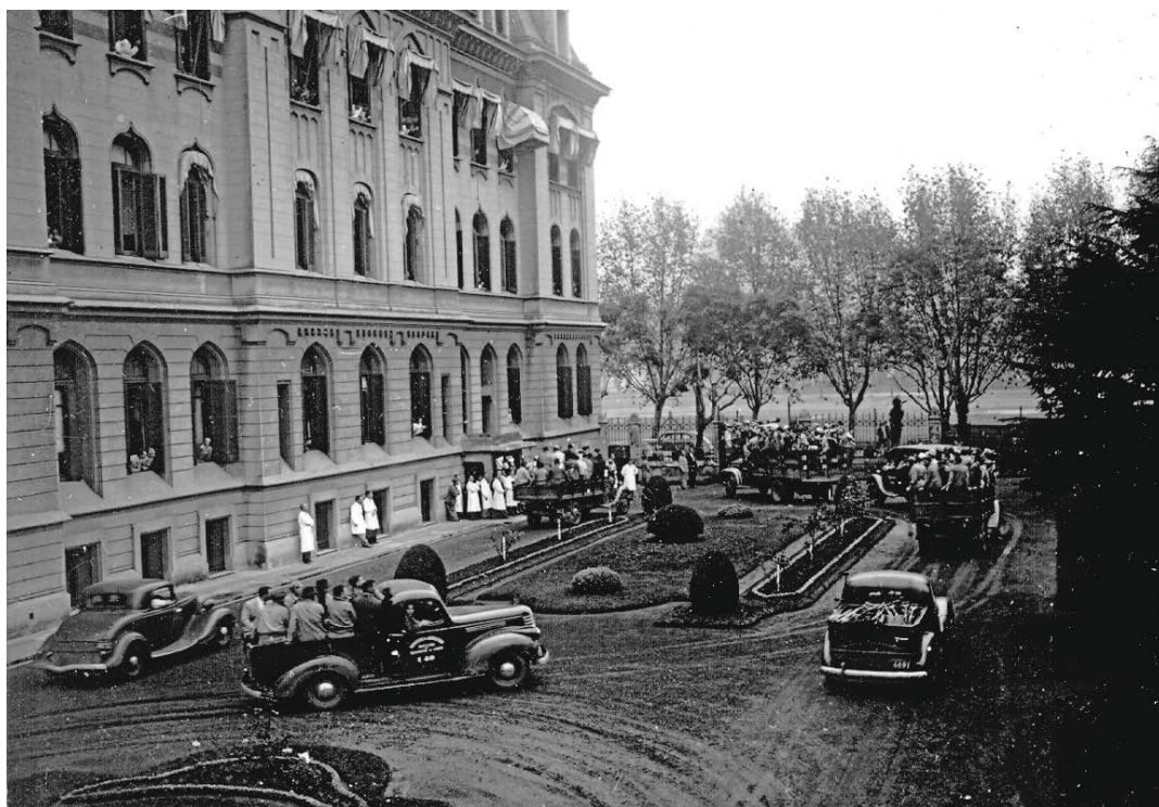
Fig. N° 34.- Fachada trasera del Edificio Paseo Colón N° 922, circa 1938. Fotografía Blanco y negro, digitalizada por el CeDIAP.
