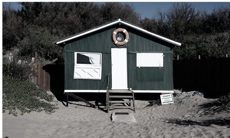
Costruida sobre pilotes, representa una adecuada forma de permitir el libre movimiento de las dunas
