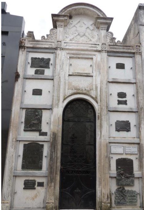
Figura 12.A. Ejemplo de Bóveda nichera.
