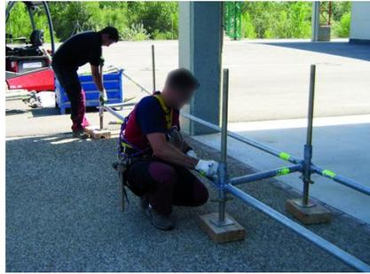
Figura N°70: Ejemplo de nivelación y reajuste de los husillos
