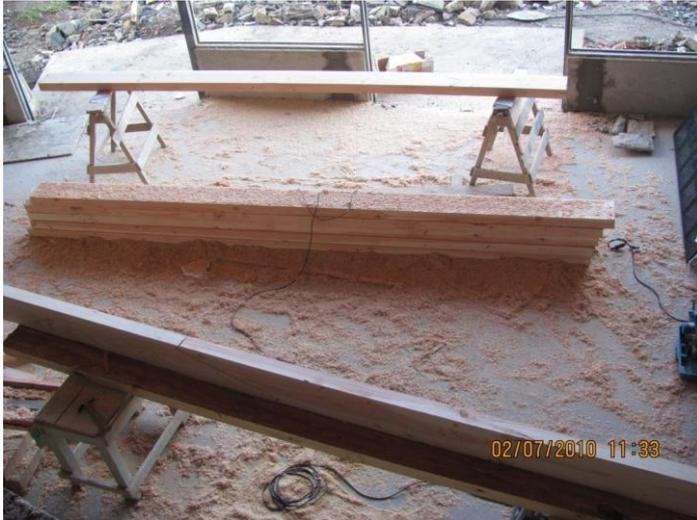
Imagen N° 5. Acopio de madera y lugar de trabajo: corte y lijado en semicubierto PB.
