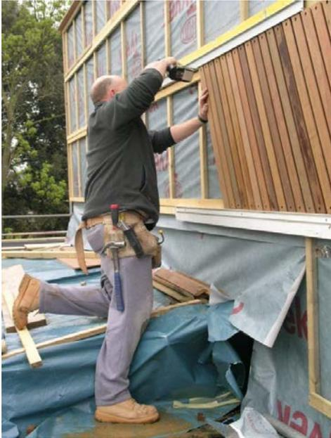
Figura N° 13: Ejemplo de montaje de madera en fachada
