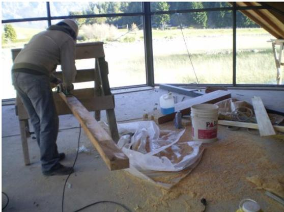
Figura N°18: Lijado de madera sin mesa de trabajo Acorde.
