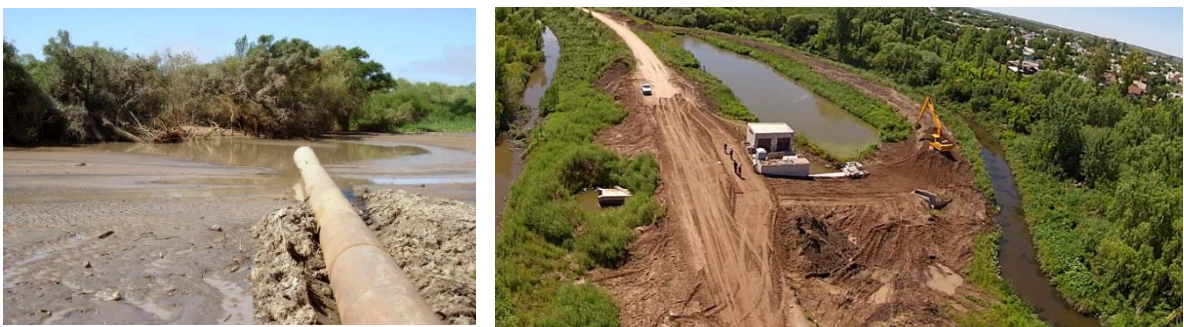
Figura 16. Imágenes del Terraplén costero en construcción. Fuente: Municipalidad de Berisso
