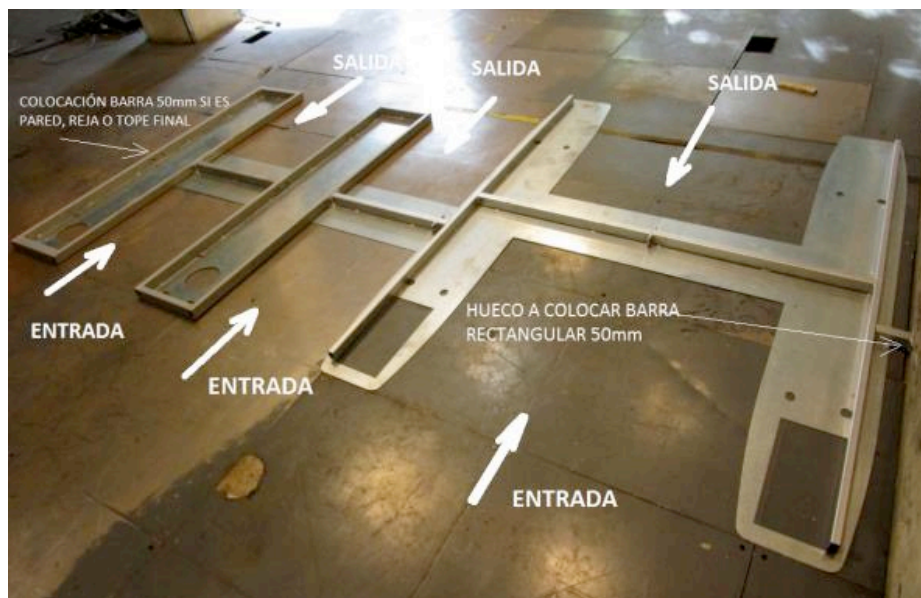
- 5 - Foto plantillas base, replanteo en obra. Fuente: Elaboración propia.
