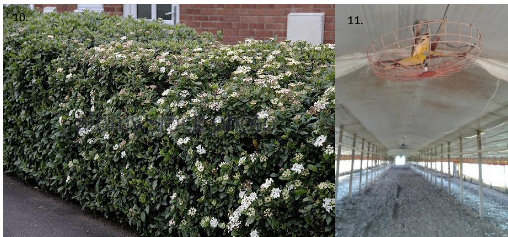
Foto 10. Seto de Viburnum tinus. Foto 11. Ventilador axial existente en tinglado.
