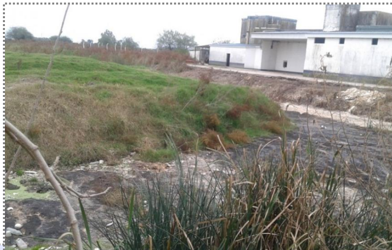
Foto 2. Intersección de canal pluvial con alcantarilla de vertido de desechos de faena avícola. Atrás: frigorífico en desuso.
