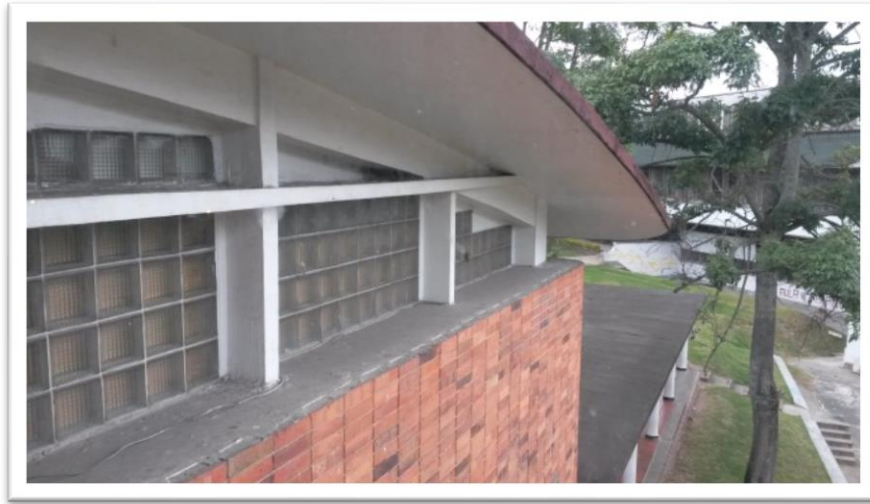
Ilustración 18. Aleros, Fachada Oriental, MALR. UNAL.
