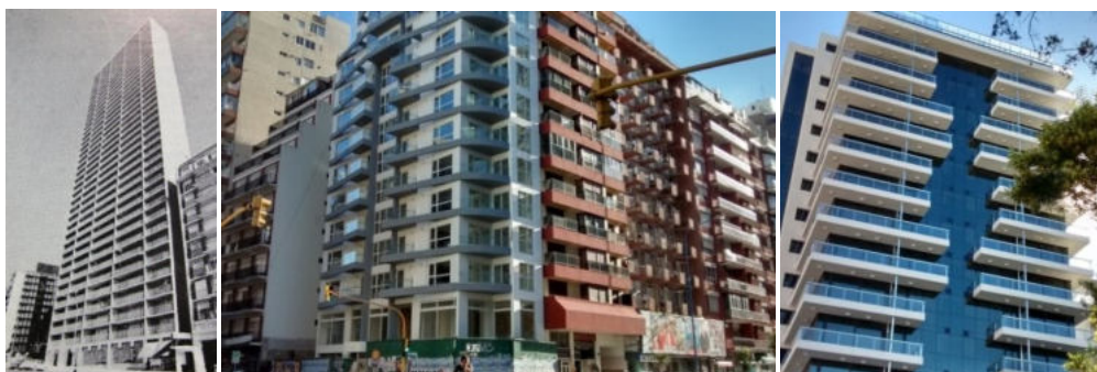
Figura 8: Fotos tipologías edilicias torres en altura desde los '60a la actualidad. Fuente: fotografías de las autoras.
