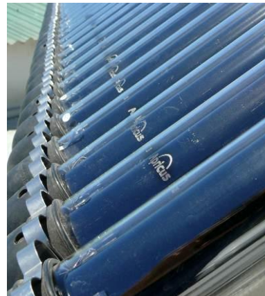
Figura 91: Las distintas tecnologías a colocar de colectores solares. De izquierda a derecha: Colector solar Plano Vademarco (Argentina), y Colector solar de tubos evacuados Apricus (Australia)
