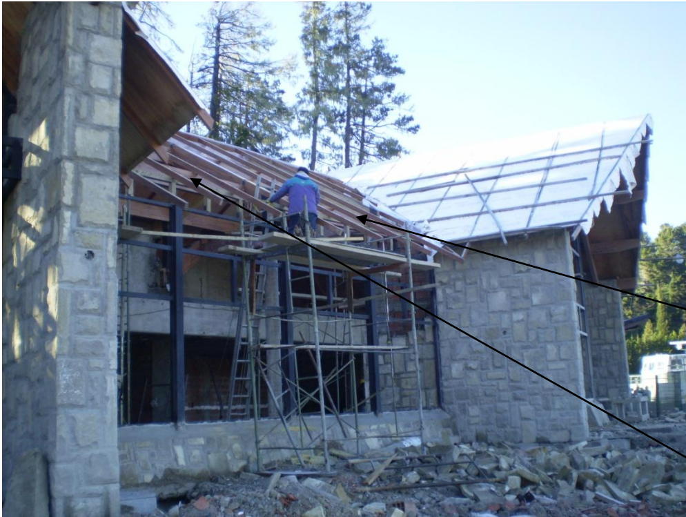
Foto 20: colocación de tirantes 2x4"
