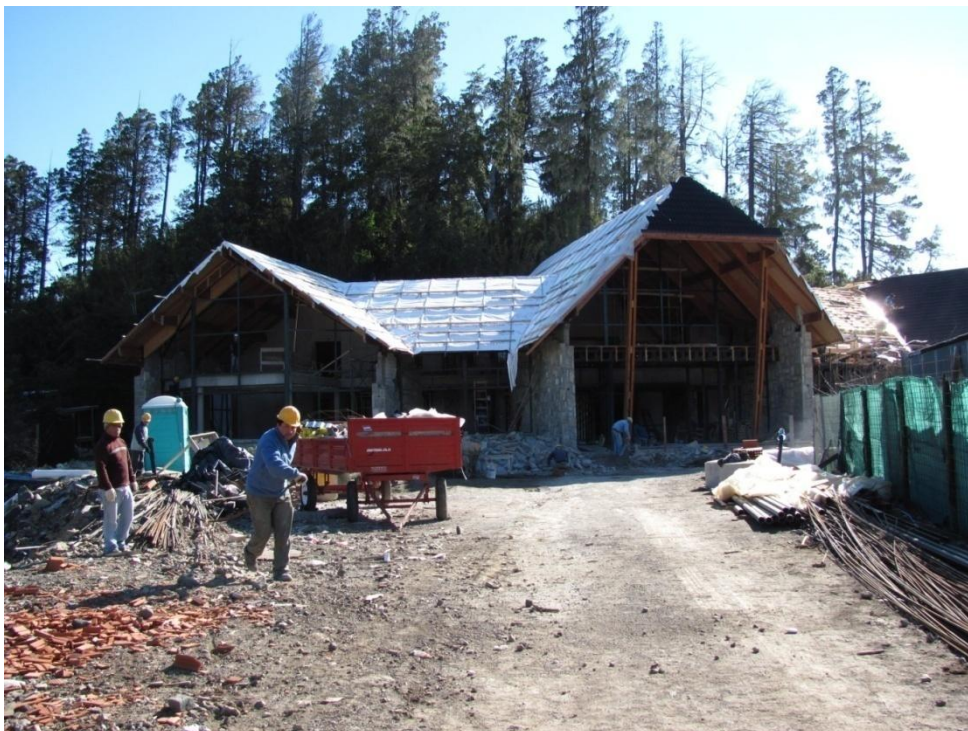
Foto 17: colocación de tejas gravilladas
