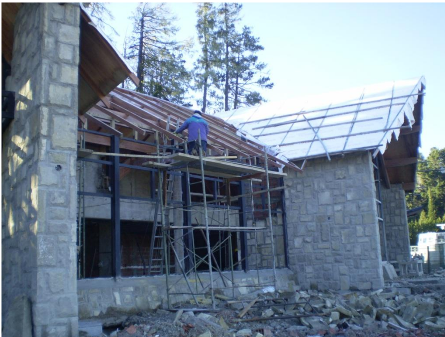
Foto 11 y 12: ubicación de tirantes 2x4" armado de andamio exterior
