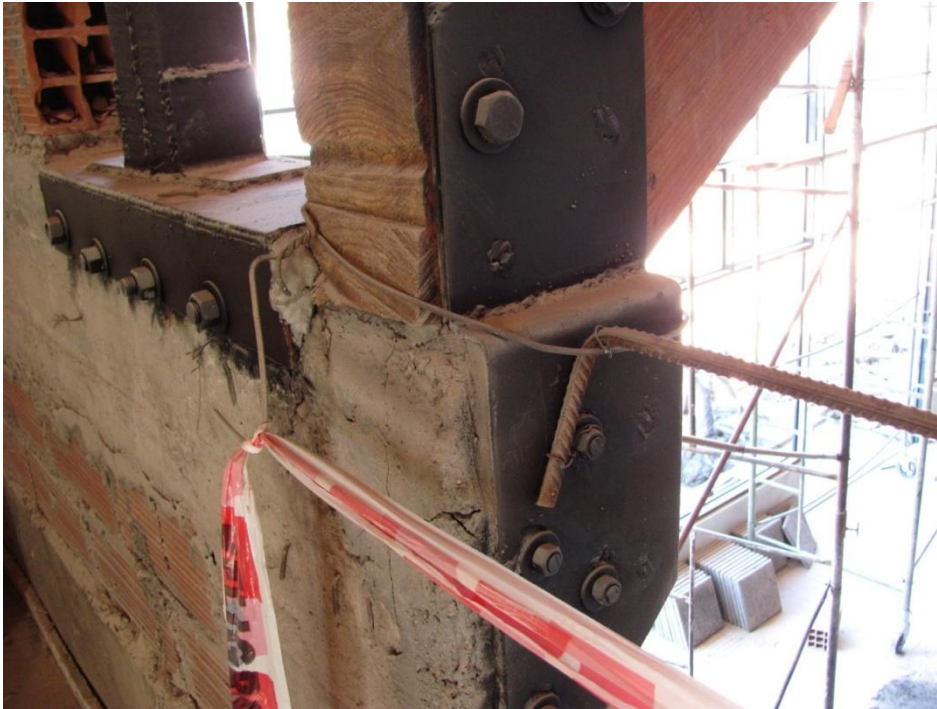
Foto 19: colocación vigas pórtico a estructura H°A°
