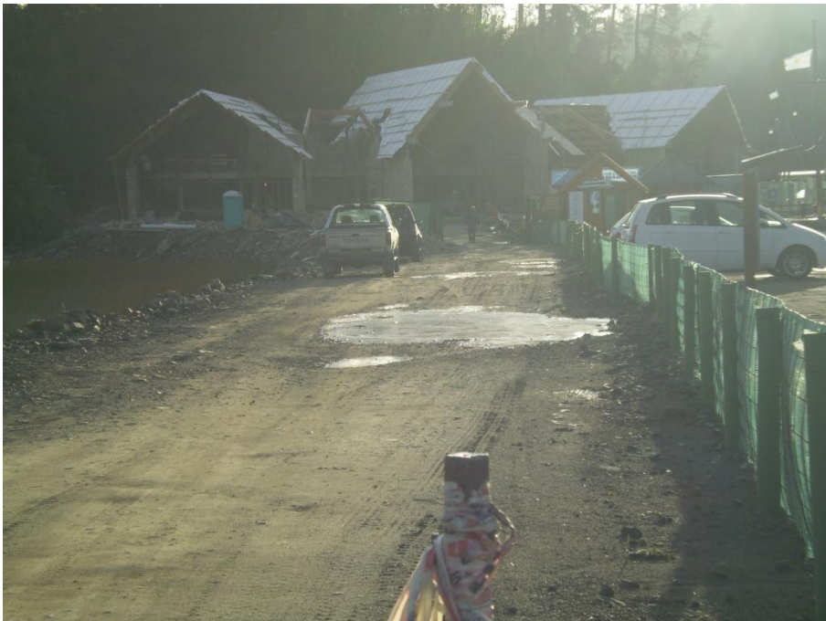
Foto 3: ingreso a la obra por único camino, el cual está vallado por parantes de madera, malla sima y media sombra verde.
