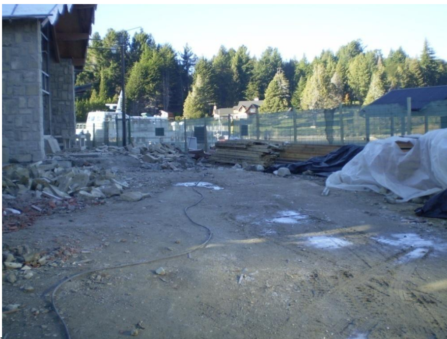
Foto 1: zona de acopio de maderas
