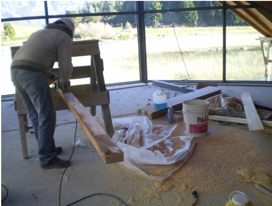
Foto 5: cortado y lijado de tirantes para techos
