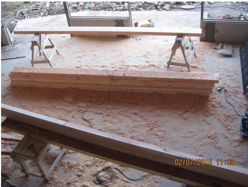
Foto 6: acopio de tirantes en PB Fuente: obra en estudio 2010
