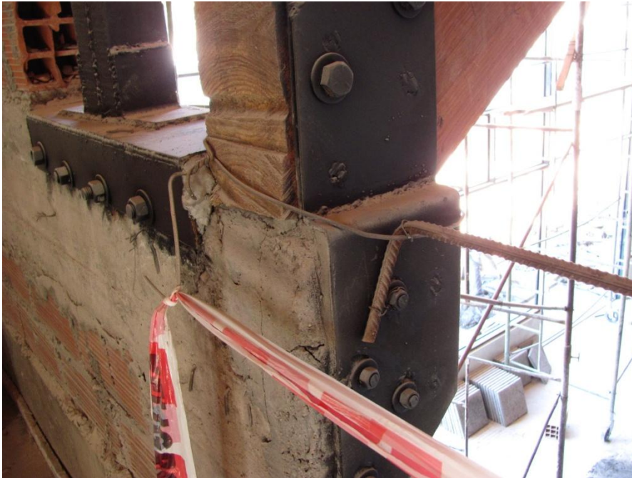
Foto 9: anclaje mediante planchuelas y bulones a la estructura de H° A°
