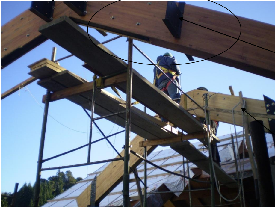
Foto 18: colocación vigas pórtico y correas
