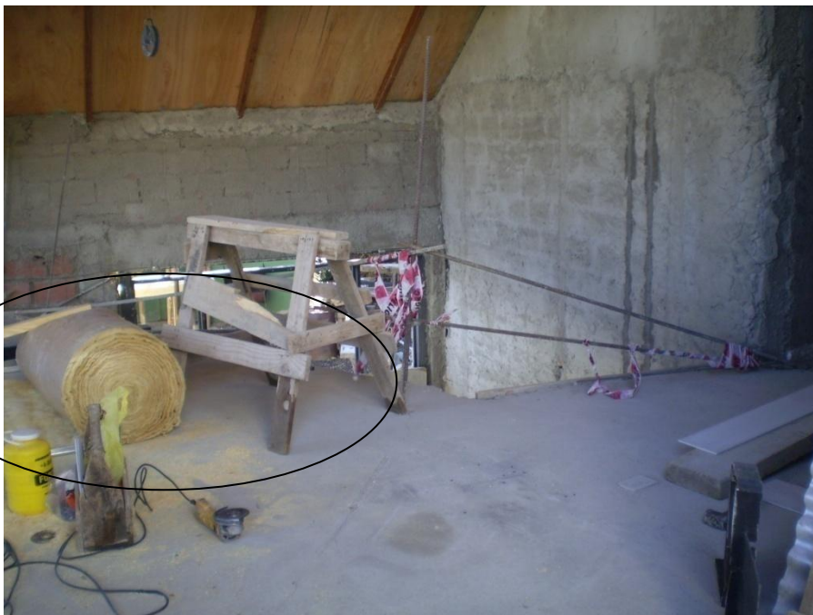
Foto 15: Acopio rollos de lana de vidrio en 1° piso
