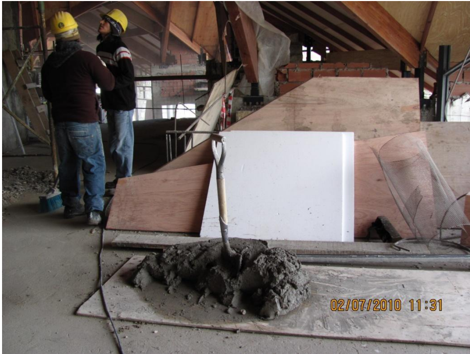
Foto 6: cortado y lijado de placas fenolicas enchapadas para techos Fuente: obra en estudio 2010
