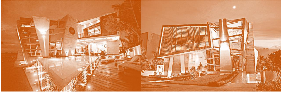
Fig. 124: Casa Gómez - Sergio Orduña. Puerto Cancún Cada hombre traza su camino. Fuente: https://www.revistadeck.com/casa-gomez/
