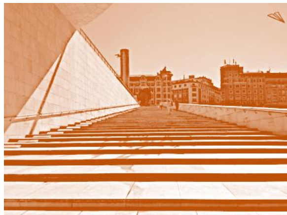
Fig. 128: Escalera de acceso.
