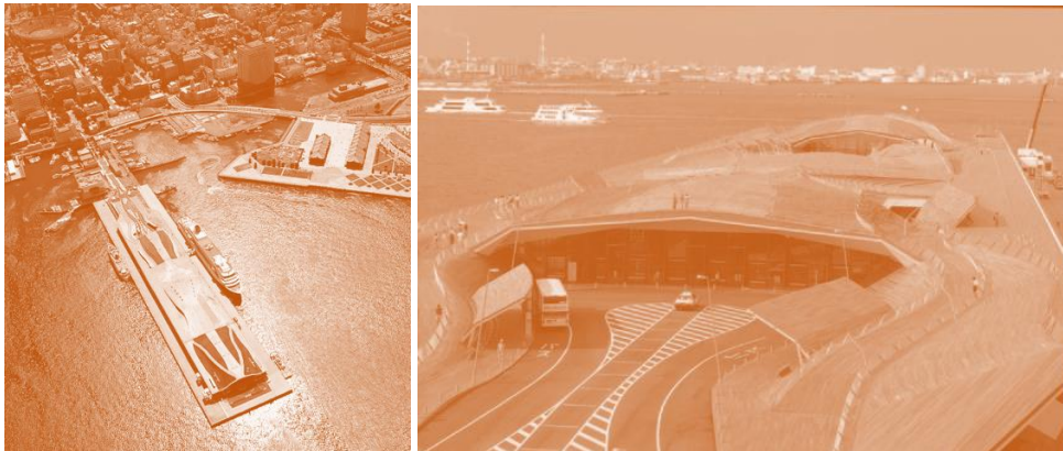
Terminal de Pasajeros de Yokohama
