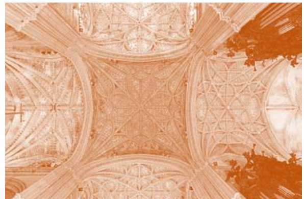
Fig. 22: Bóveda de Estrella - Catedral de Sevilla
