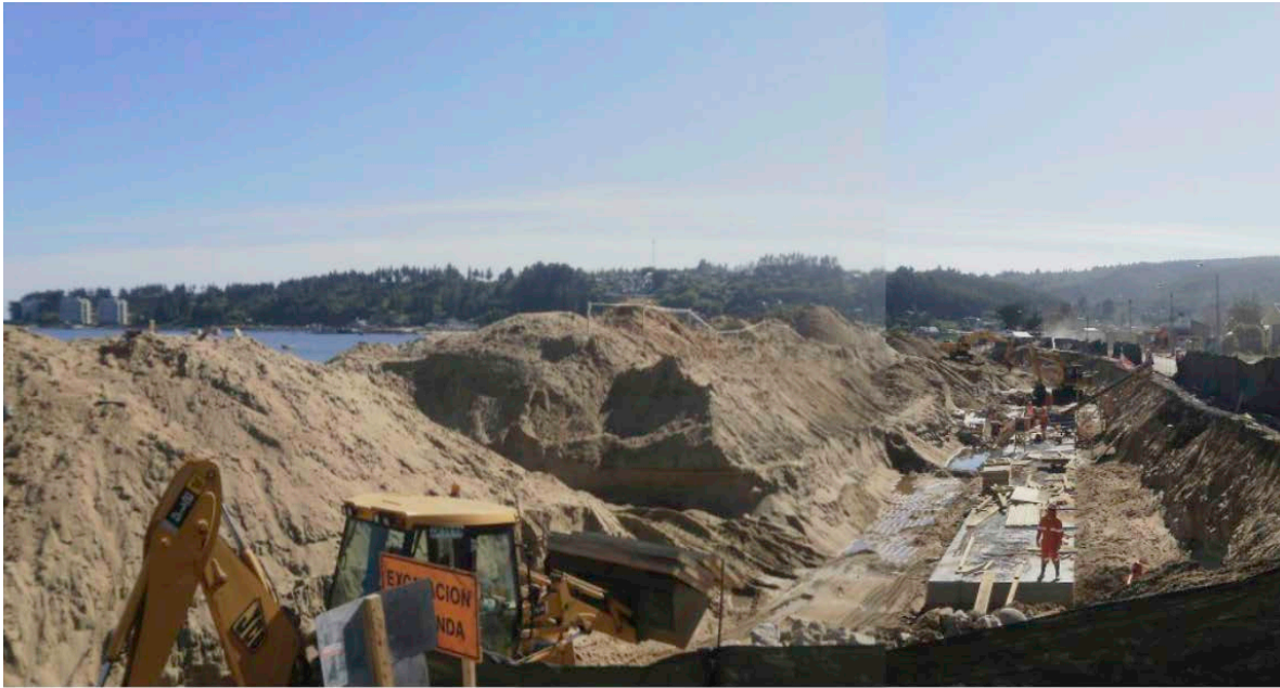
Fig. 102. Ejecución del muro rompeolas del Parque de Mitigación del Borde Costero. En la imagen se observa la magnitud de las obras civiles de las estructuras de fundación del muro rompeolas, que posteriormente darán lugar sostener el parque y su nuevo nivel topográfico según se señala en la imagen anterior. Fuente: Baeriswyl, Sergio (2011).
