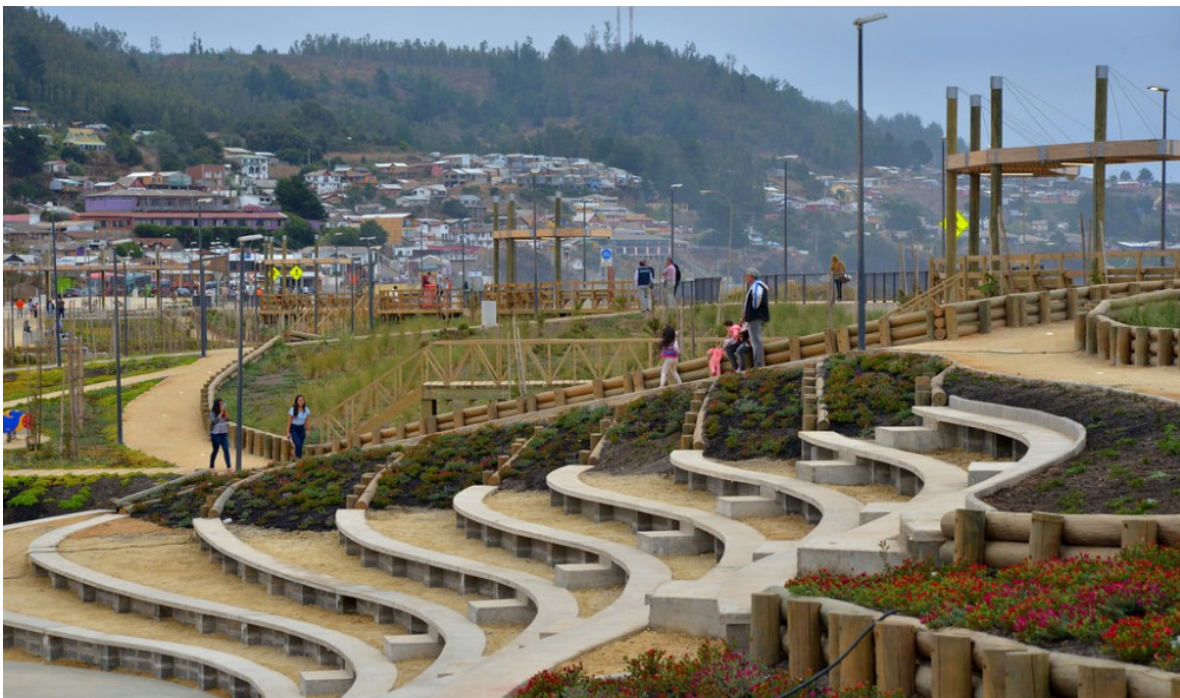
Fig. 91. Modelamiento topográfico de dunas en Parque de Mitigación de Pelluhue. Contención mediante gradas de hormigón. Fuente: Autor, 2017.
