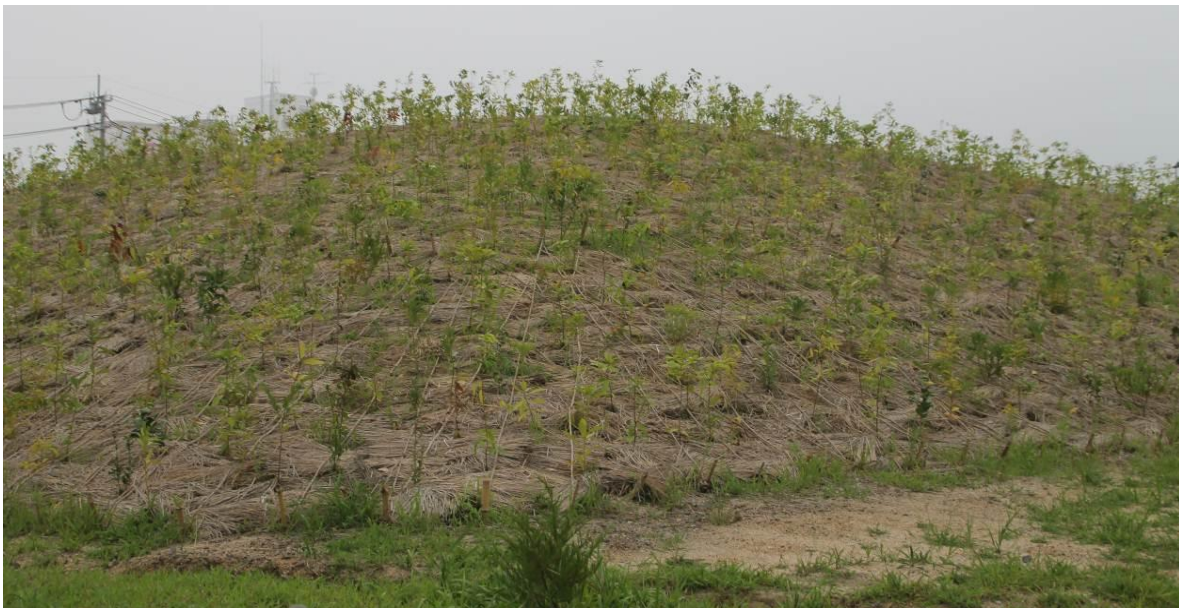
Fig. 61. Bosque de mitigación en la ciudad costera de Iwanuma, Japón. El proyecto forma parte del plan de reconstrucción urbana, post tsunami de 2011. Como se observa en la sección de abajo, el Bosque se desarrolla sobre un sistemas de colinas artificiales levantadas a partir de la acumulación de escombros generados por el tsunami, los cuales son estabilizados y luego cubierto por tierra vegetal apta para recibir las plantaciones de árboles. Fuente: Reconstruction Plan for Iwanuma, en Renaud & Murti, 2013.
