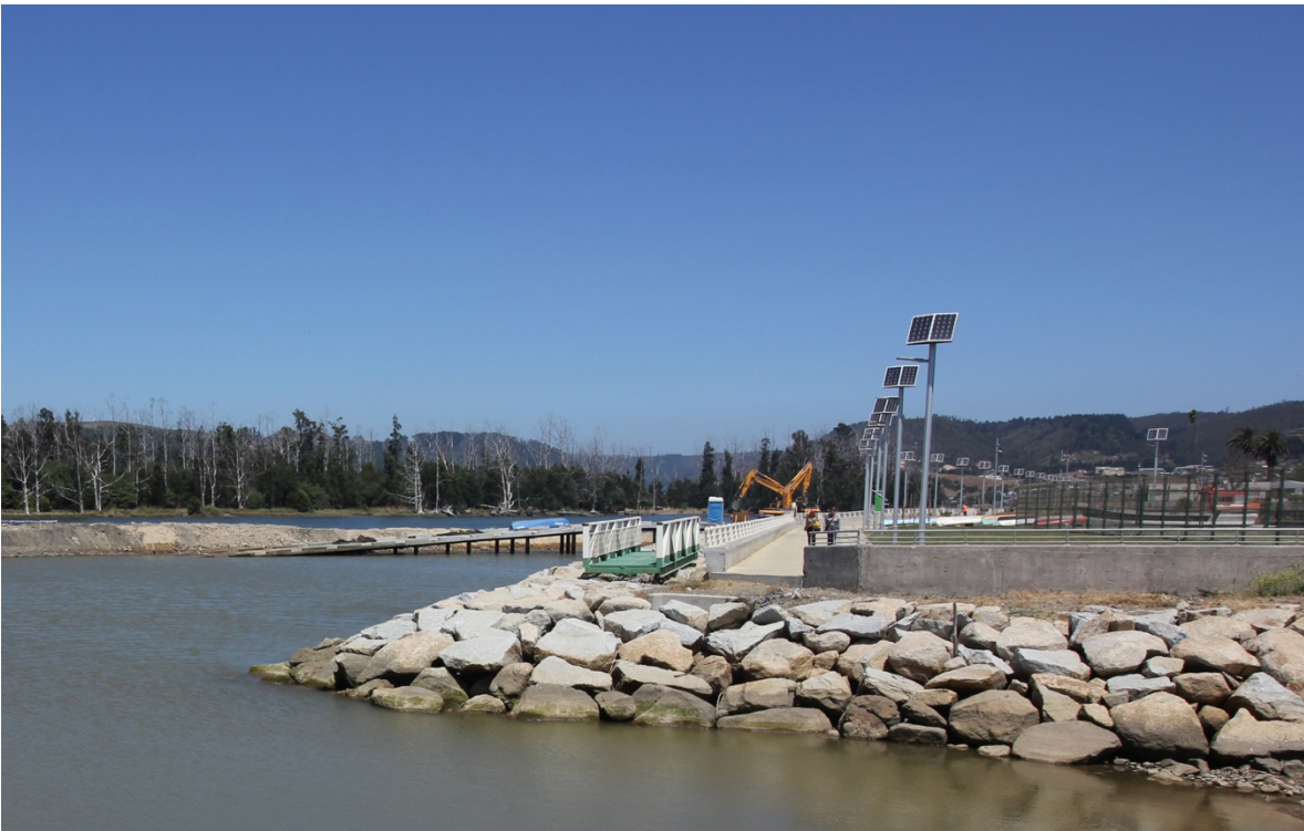
Fig. 69. Imagen aérea de la escollera y muro de contención, en el extremo norte del Parque de Mitigación de Constitución. Fuente: Autor, 2019.
