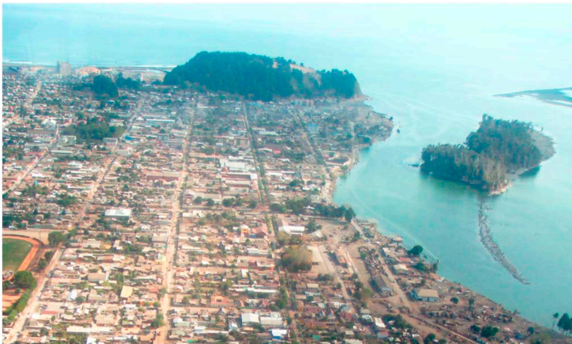
Fig. 49. Vista aérea de Constitución post 27F, 2010. En la imagen tomada hacia el nor-oeste se observa el plano de ciudad parcialmente destruido por el ingreso del tsunami a través de la desembocadura del río Maule, el cual previamente arrasó con la infraestructura turística de Isla Orrego, que aparece a la derecha de la imagen. Parte de los habitantes ubicados en la zona afectada lograron resguardarse en el cerro Mutrún, que se observa en la parte superior, al centro de la fotografía. Fuente: PRES (2011).
