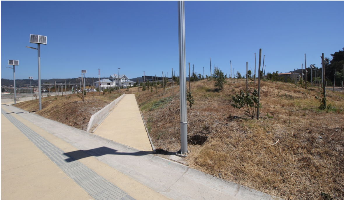
Fig. 72. Imagen de movimientos topográficos con cobertura vegetal para la conformación de colinas en el Parque de Mitigación de Constitución. Proyecto en fase avanzada de ejecución. Fuente: Autor (2019).
