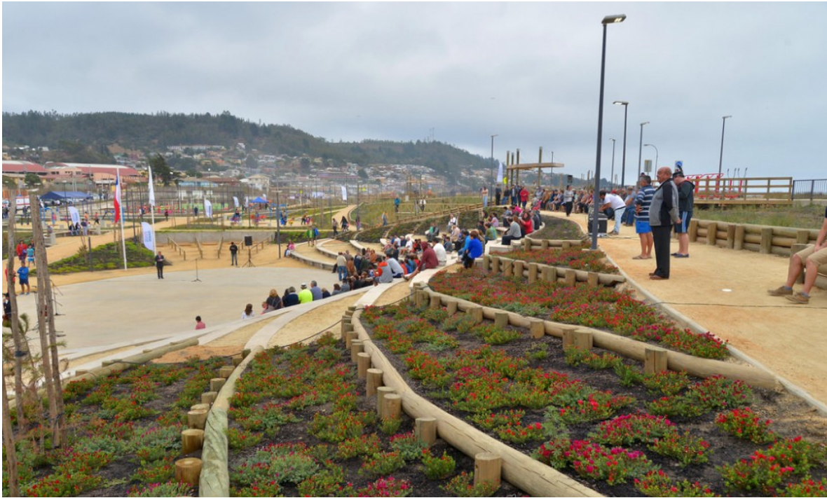
Fig. 90. Modelamiento topográfico y fitoestabilización de dunas en Parque de Mitigación de Pelluhue. Contención mediante pilotaje. Fuente: Autor, 2017.
