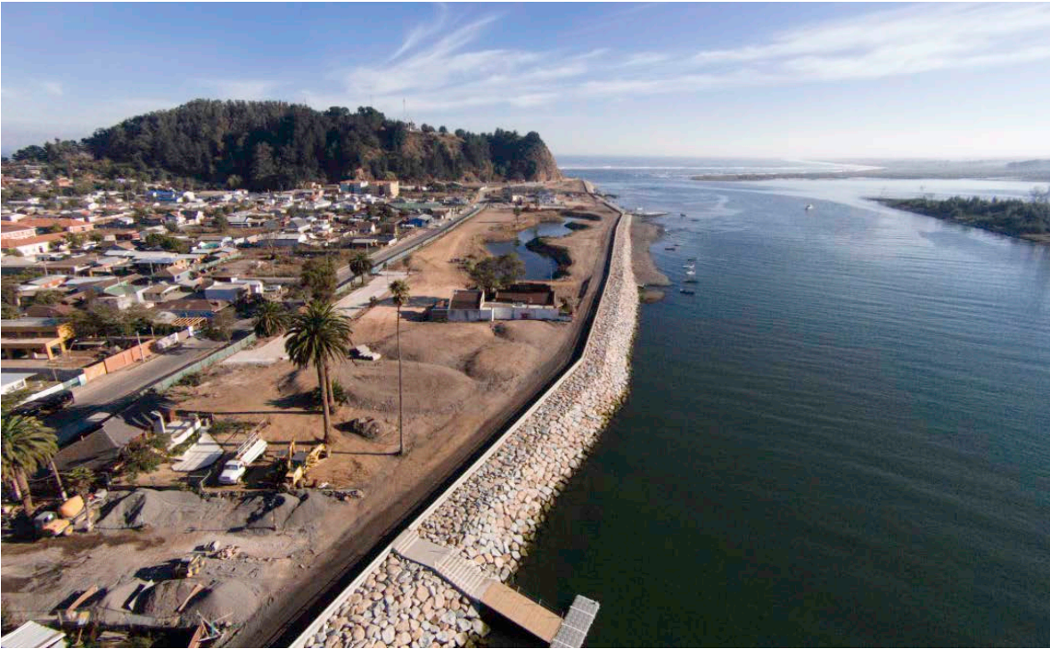
Fig. 68. Imagen aérea de la escollera y muro de contención del Parque de Mitigación de Constitución. Fuente: Autor, 2017.
