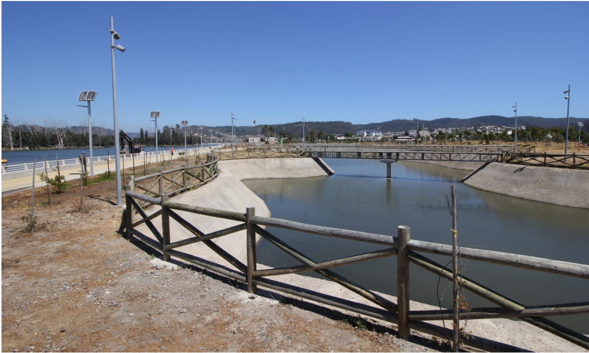
Fig. 74. Laguna inundable de acumulación en el sector norte del Parque de Mitigación de Constitución, con capacidad estimada de 30.000 metros cúbicos. Proyecto en fase avanzada de ejecución. Fuente: Autor (2019).
