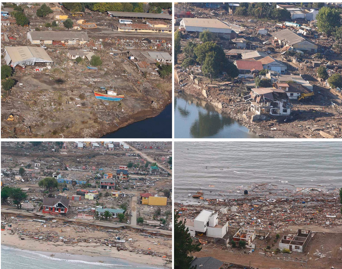
Fig. 35. Arriba: Destrucción en el borde fluvial de Constitución, región del Maule, afectado por el ingreso del tsunami a través de la desembocadura del río Maule. Abajo: Impacto y destrucción producido por el tsunami en el borde costero de Dichato, región del Biobío. Como se observa en ambas secuencias de imágenes, las edificaciones de vivienda y otros usos colindaban con la ribera del río y el borde costero, respectivamente, en una condición de alta vulnerabilidad que finalmente derivó en la destrucción total de ambos frentes urbanos. Actualmente, tal como se observa en las Cartas de Inundación, previamente presentadas, el borde fluvial y costero es declarado zona de riesgo y, como se señala más adelante, es justamente el espacio destinado a los Parques de Mitigación, en ambas localidades. Fuente: EMOL ( https://www.emol.com/especiales/2010/fotos_AD/terremoto_chile_aereas/ )
