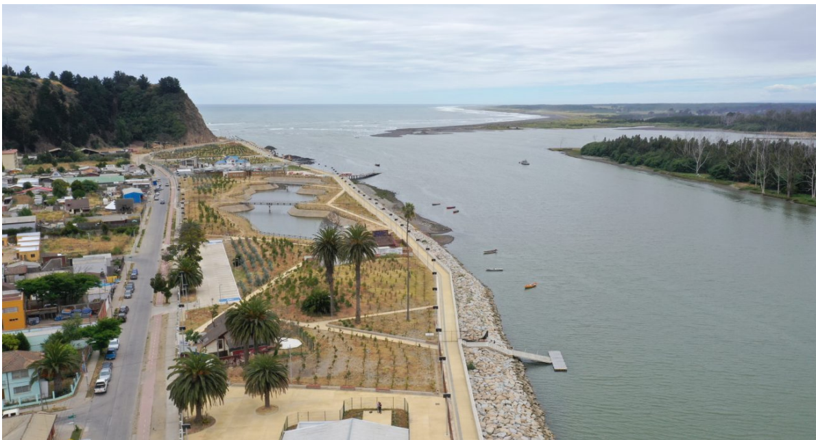
Fig. 75. Vista panorámica del sector norte del Parque de Mitigación de Constitución, con la laguna inundable. Proyecto en fase avanzada de ejecución. Fuente: Autor (2019).
