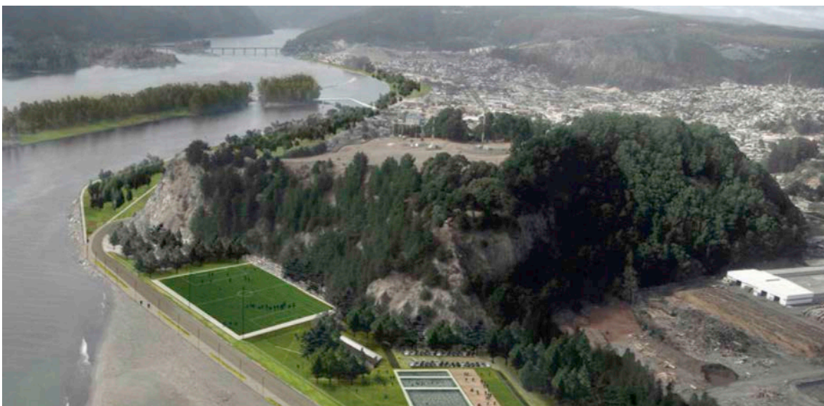
Fig. 56. PRES Constitución, Imagen objetivo del sistema de mitigación de inundación por tsunamis, en el borde costero y fluvial. Arriba: se observa la vista aérea de la ciudad después del impacto del tsunami, evidenciando un alto grado de exposición de la zona industrial – en el borde costero hacia el costado derecho de la imagen – y de la zona urbana adyacente a la ribera del río Maule. Al Centro y Abajo: se grafica el alcance del sistema de mitigación, conformado de manera continua por un parque costero que enfrenta al océano Pacífico y protege la zona industrial, seguido de un parque fluvial en la ribera sur, que protege la zona urbana central de Constitución. Fuente: PRES (2011).
