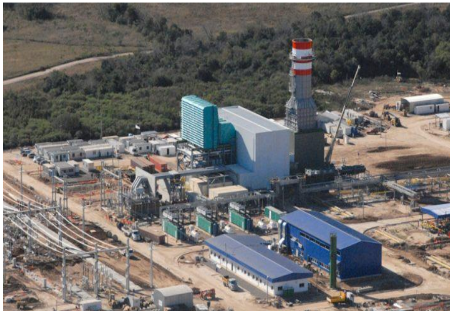
Figura 108. Central Termoelectrica de Ensenada de Barragán
