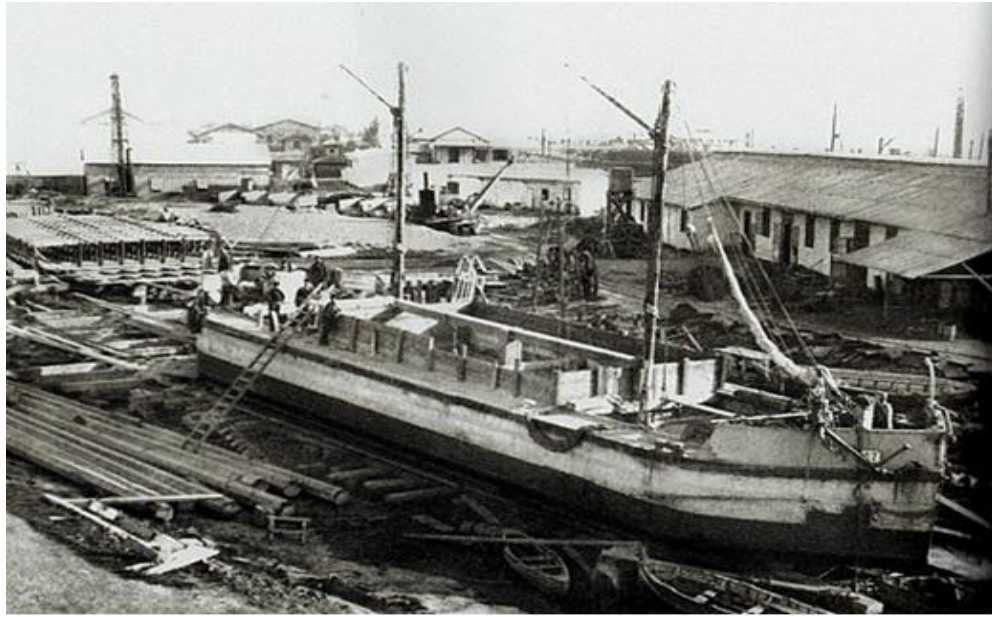
Figura 13. Trabajos en el Astillero Rio Santiago
