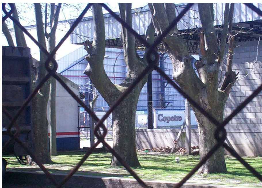
Figura 119. Copetro, planta de tratamiento de coque en Ensenada
