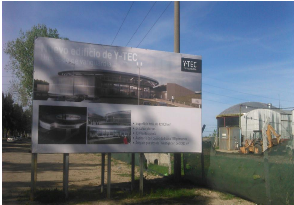
Figura 104. YTEC CONICET, inicios de la obra
