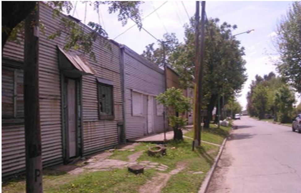
Figura 66. Fachadas de casas de chapa típicas en la ciudad de Ensenada
