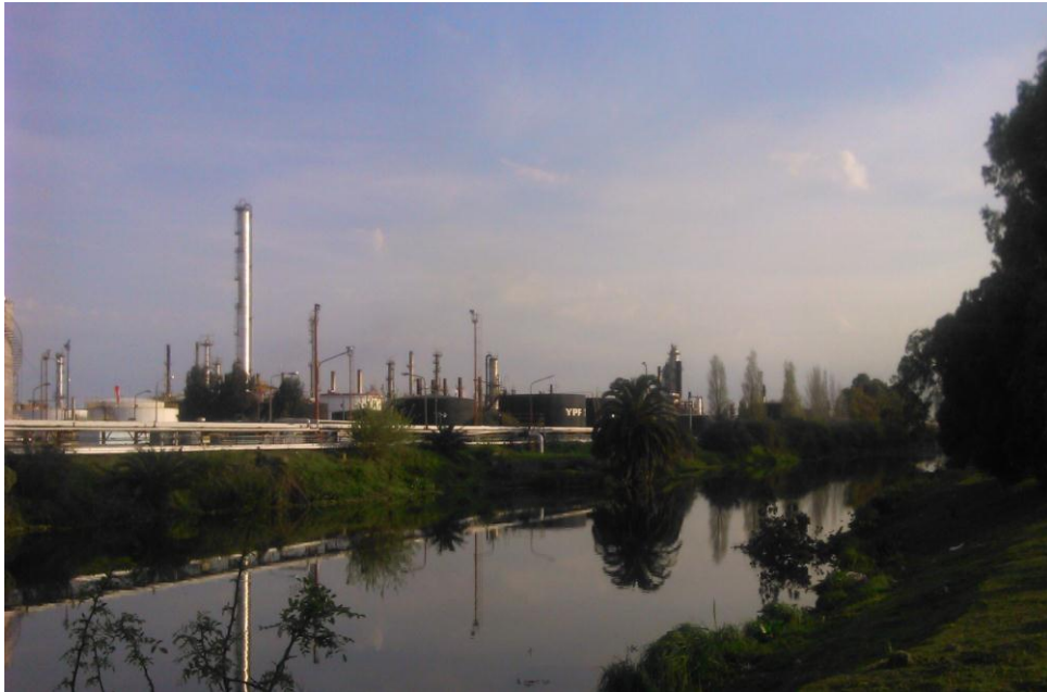
Figura 101. La Refinería YPF-La Plata y los canales
