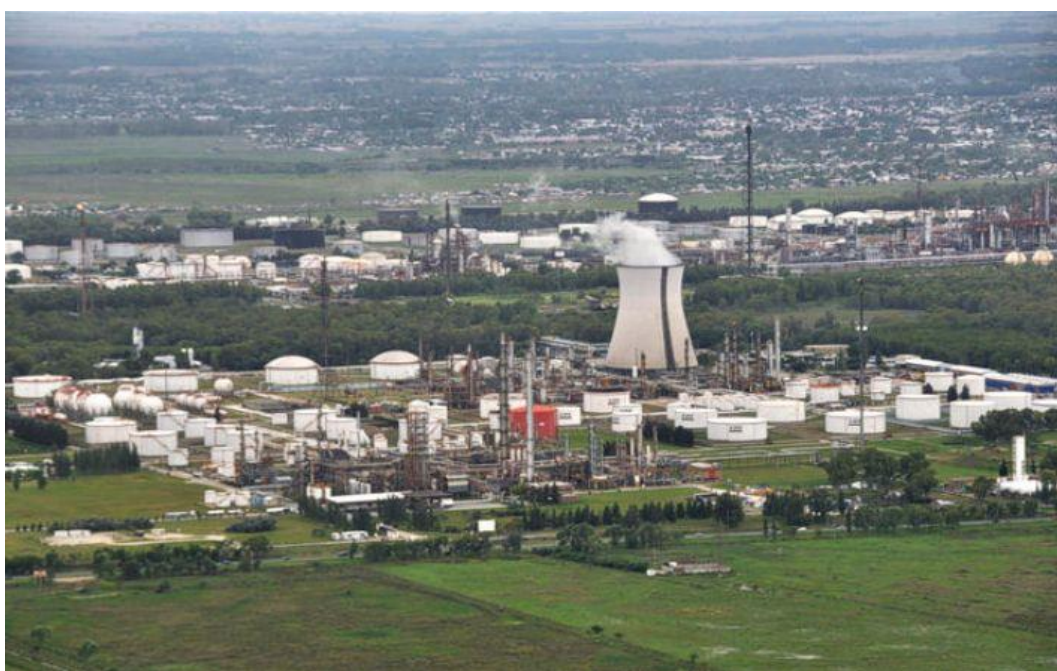
Figura 36. Petroquímica General Mosconi
