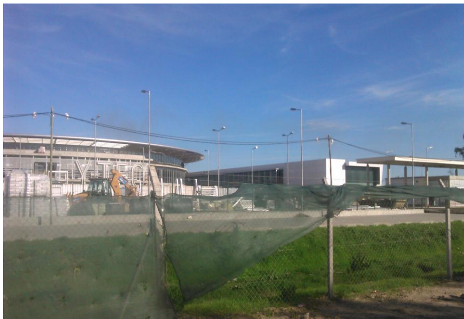
Figura 105. YTEC CONICET, obra en construcción
