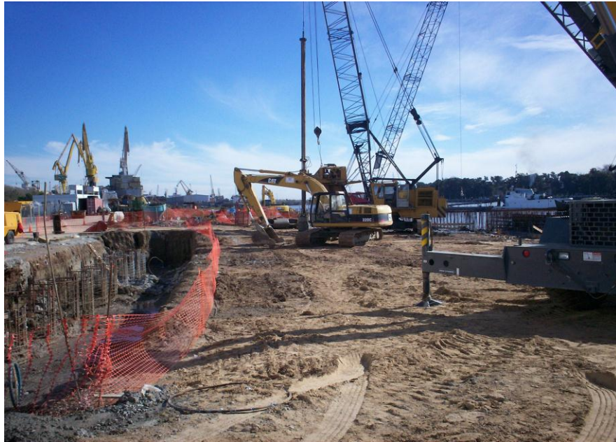
Figura 107. Obras de relleno para TEC Plata
