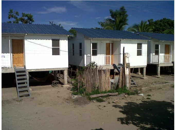
Figura 32. Conjunto de VIS desarrolladas con el sistema constructivo Corpacasa en la ciudad de Barranquilla. Fuente: http://www.corpacero.com/Productos/Paginas/Corpacasa.aspx
