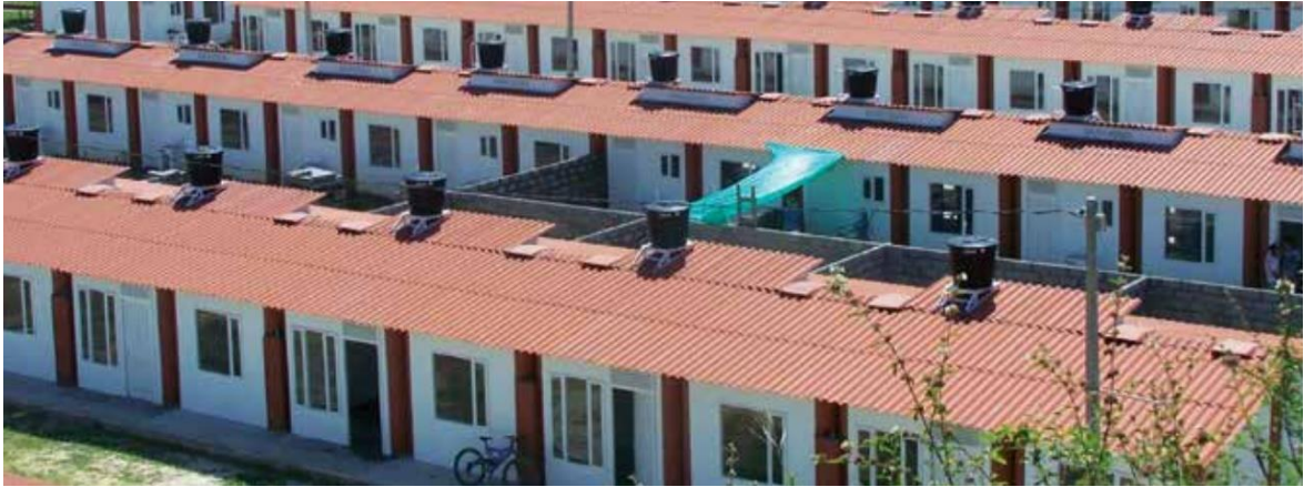
Figura 21. Urbanización desarrollada con el sistema constructivo Vivienda Celular Eternit. Fuente: Eternit (ETERNIT, 2017).
