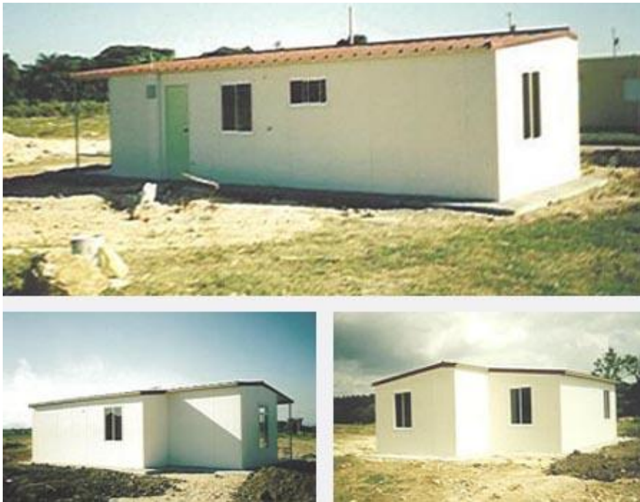
Figura 28. Soluciones de VIS de 36m 2 y 56m 2 desarrolladas con el sistema constructivo Metecno. Fuente: http://www.metecnocolombia.com/viviendas/montajecasa.html
