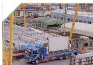
4. Transporte e izaje de los paneles
