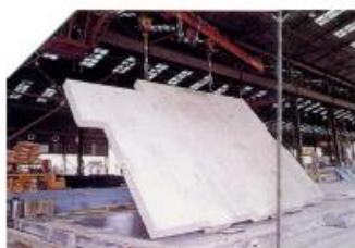
3. Desmolde y almacenaje de los paneles
