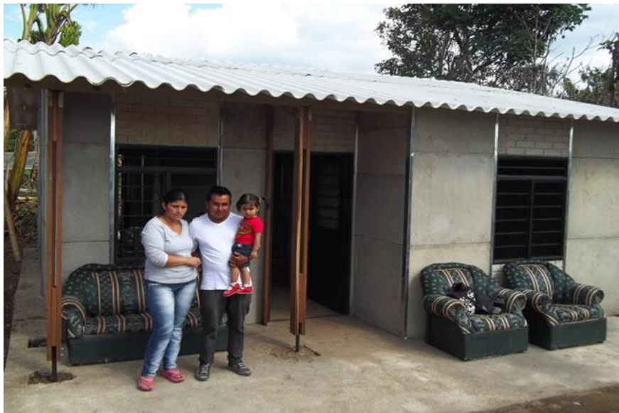
Figura 27. Aspecto exterior de una VIS construida con el sistema constructivo Servivienda. Fuente: http://www.jesuitas.org.co/noticia.html?noticia_id=479
