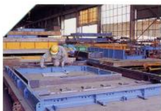
1. Adecuación de formaletas y colocación de refuerzo
