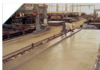
2. Colocación y afinado del concreto
