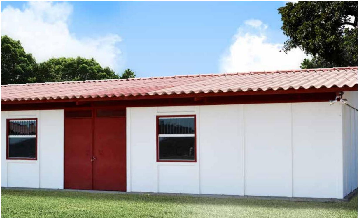
Figura 22. Vista exterior de una VIS con sistema constructivo Plycem 1000. Fuente: https://www.plycem.com/contenido/wp-content/uploads/2016/01/Manual-Sistemas-1000-25-enero-2016.pdf
