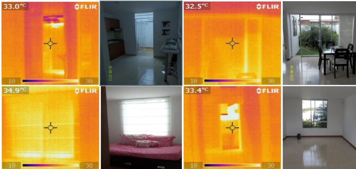
Figura 39. Termografías interiores de una VIS con envoltente de concreto reforzado. Fuente: (Barona, 2016).
