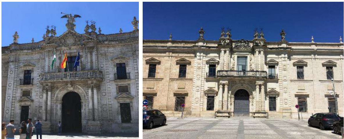
Figura 9-7. Real Fábrica de Tabacos. Fachada ppal. (iz.) fachada Sudeste (der.)
