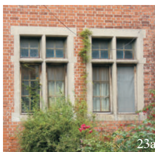
Fig.N°21a: ventana con hojas a guillotina, colegio San Jorge, arq. James Frammer; Fig.N°21b: ventanas apareadas con hojas guillotina y postigos metálicos, Colegio Secundario San Jorge, arq. James Frammer; Fig.N°21c: corte perspectivado de ventana con hojas a guillotina según Johnson (2006:143:Fig.150) y herrajes para hojas guillotina según Johnson, cierres (sash fastener, "fitch"sash fastener, sash lift) y elevador (2006:146: Fig.153, Fig.154, Fij.155); Fig.N°21d: Ventana con hojas a guillotina y mosquitero, casa Oldham; Fig.N°21e: ventanas de ferrocarril con hojas y postigos a guillotina; Fig.N°22a: vidrio fijo decorado, carpintería metálica, casa Brass; Fig.N°22b: ventanas y postigos de hierro, casa Brass; Fig.N°23a: ventanas con perímetro y divisiones verticales en bloques de piedra, Capilla Colegio San Jorge, arqs. Chambers y Thomas; Fig.N°23b: ventanas con perímetro en revoque símil piedra, Iglesia Presbiteriana; Fig.N°23c: ventanas en hierro con vitreaux, Iglesia Anglicana, arq. Bassett-Smith.
