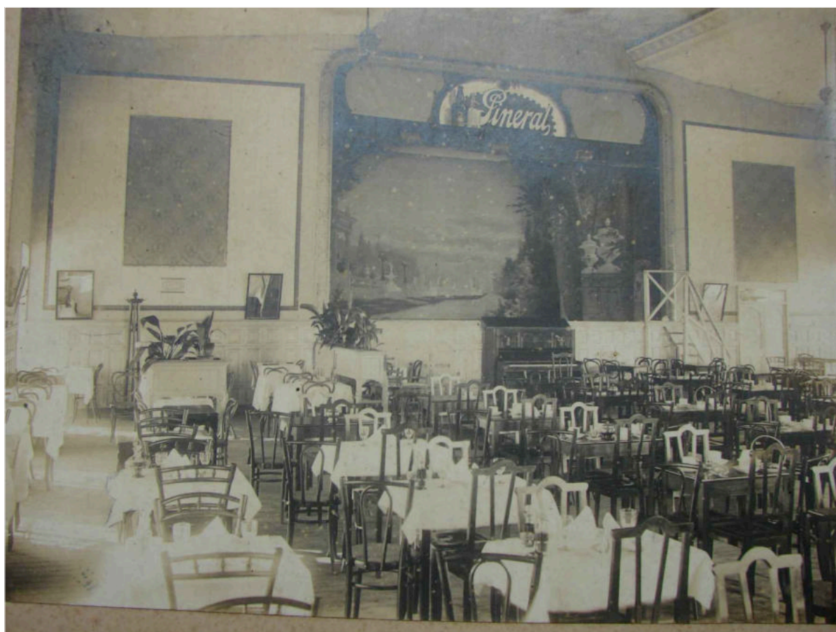
Fig. Nº119: Galería sobre la Rambla noreste Fig. Nº120: Gran salón en la Rambla noreste
