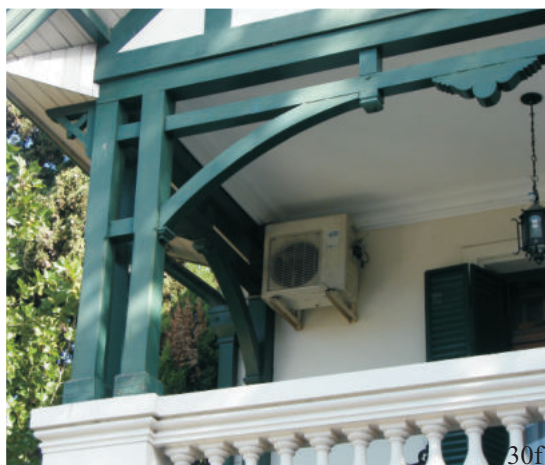
Fig.Nº30 a, b: estructura de vigas compuestas y ménsulas que conforman arcos; cubierta sobre andenes, estación Quilmes. Fig.Nº30 c, d: columnas en galería y detalle de falso capitel, casa Oldham. Fig.Nº30e: detalle de arcos conformados por piezas que ofician de ménsulas, galería en casa Gardner. Fig.Nº30f: estructura de madera para sostén de cubierta, variante de viga compuesta, ménsulas y doble columna, casa Juster, arq. Zündt. Fig.Nº30g: ménsulas para sostén de alero en cuerpo ochavado, casa Álvarez de Toledo. Fig.Nº30h: pendolón en remate de cumbre, casa Lander.
