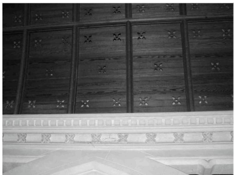
Fig. N°8: Vista interior de la nave Fig. N°9a: Vista del arco en el presbiterio Fig. N°9b: Detalle de cielorraso y friso superior
