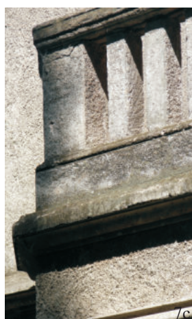
Fig.Nº3 b, c, d: terminaciones en revoque simil piedra, Iglesia Presbiteriana; Fig.Nº6b: porche con arcos de medio punto de ladrillo de máquina, casas D.Bell; Fig.Nº7a: revoque cementicio salpicado con perímetro de aberturas moldurado, casa Oldham; Fig.Nº7b: moldura media, revoque cementicio salpicado, casa Oldham; Fig.Nº7c: detalle de balaustres en balcón y molduras, revoque cementicio salpicado, casa Oldham; Fig.Nº8a: revoque cementicio salpicado con esquinas encadenadas y cornisa de ladrillo visto, vivienda para personal docente en Colegio San Jorge; Fig.Nº9a: ornamento y texturas contrastantes, enlucido a la cal, detalle sobre calle Gaboto, estación Quilmes.
