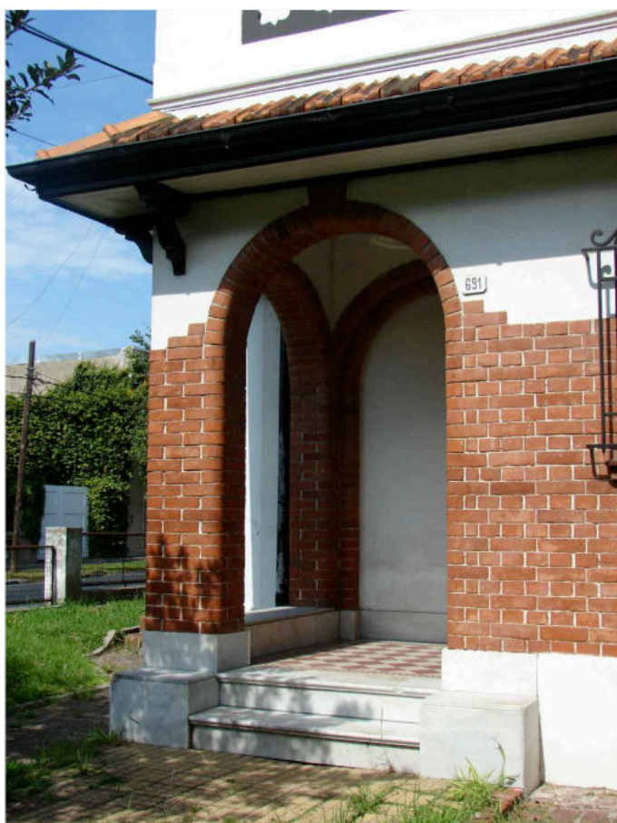
Fig. N°334: Acceso Fig. N°335: Porche de acceso Fig. N°326: Arcos de medio punto convergentes
