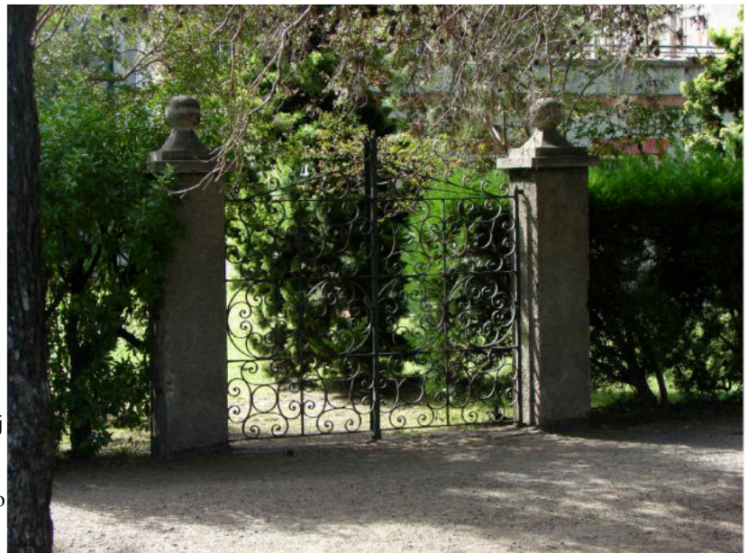
Fig. N°76: El acceso y la torre del reloj Fig. N°77: Escalera a planta alta Fig. N°78: Vista del cuerpo lateral noroeste sobre la calle Guido Fig. N°79: Portón sudoeste con acceso desde calle interna
