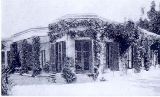
Fig. N°47b: Casa quinta Rooke Fig. N°47a: Vista de la galería noreste Fig. N°49: El antiguo edificio principal producto de las sucesivas modificaciones a la antigua casa quinta.
