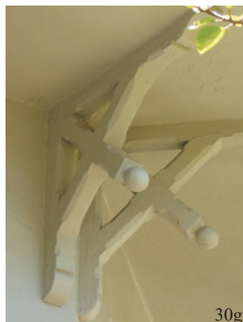
Fig.Nº30 a, b: estructura de vigas compuestas y ménsulas que conforman arcos; cubierta sobre andenes, estación Quilmes. Fig.Nº30 c, d: columnas en galería y detalle de falso capitel, casa Oldham. Fig.Nº30e: detalle de arcos conformados por piezas que ofician de ménsulas, galería en casa Gardner. Fig.Nº30f: estructura de madera para sostén de cubierta, variante de viga compuesta, ménsulas y doble columna, casa Juster, arq. Zündt. Fig.Nº30g: ménsulas para sostén de alero en cuerpo ochavado, casa Álvarez de Toledo. Fig.Nº30h: pendolón en remate de cumbre, casa Lander.
