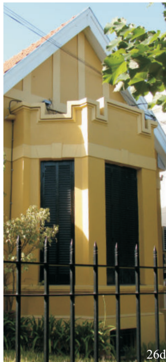
Fig.Nº26a: Oriel window1, según Johnson (2006:139:Fig.143). Fig.Nº26b: cuerpo proyectado de carpintería apoyado sobre ménsulas, casa Pennington. Fig.Nº26c: bay window de un nivel con balcón superior, casa Oldham. Fig.Nº26d: bay window con remate almenado, calle Alem y Libertad; Fig.Nº26e: bay window de dos niveles con cubierta propia, casa San José. Fig.Nº26f: cuerpo saliente de ángulos rectos con remate almenado, casa para directivo de Cervecería.
