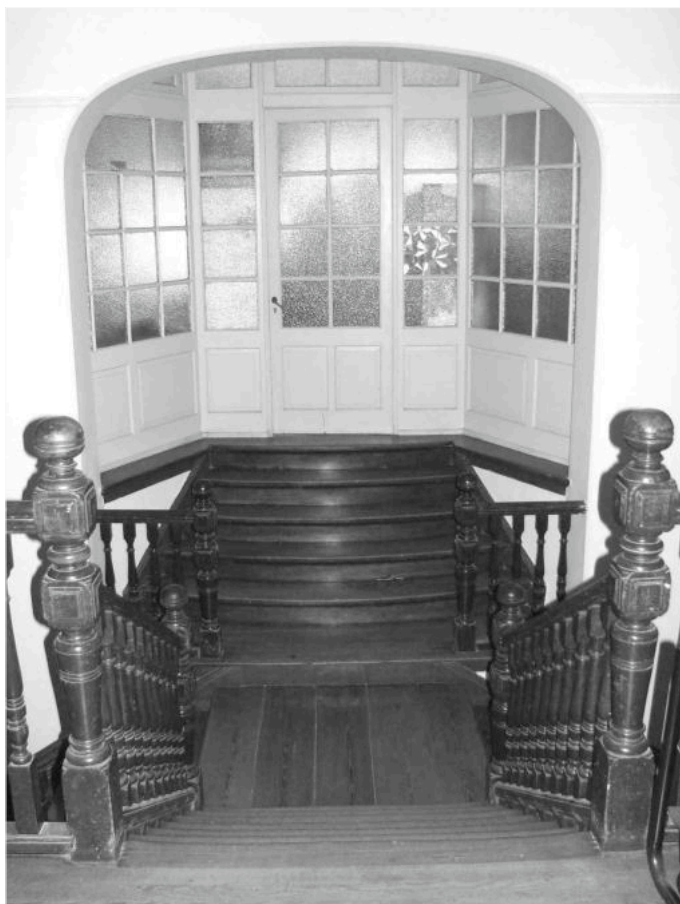
Fig. N°170: Uno de los dos tramos simétricos de la escalera
