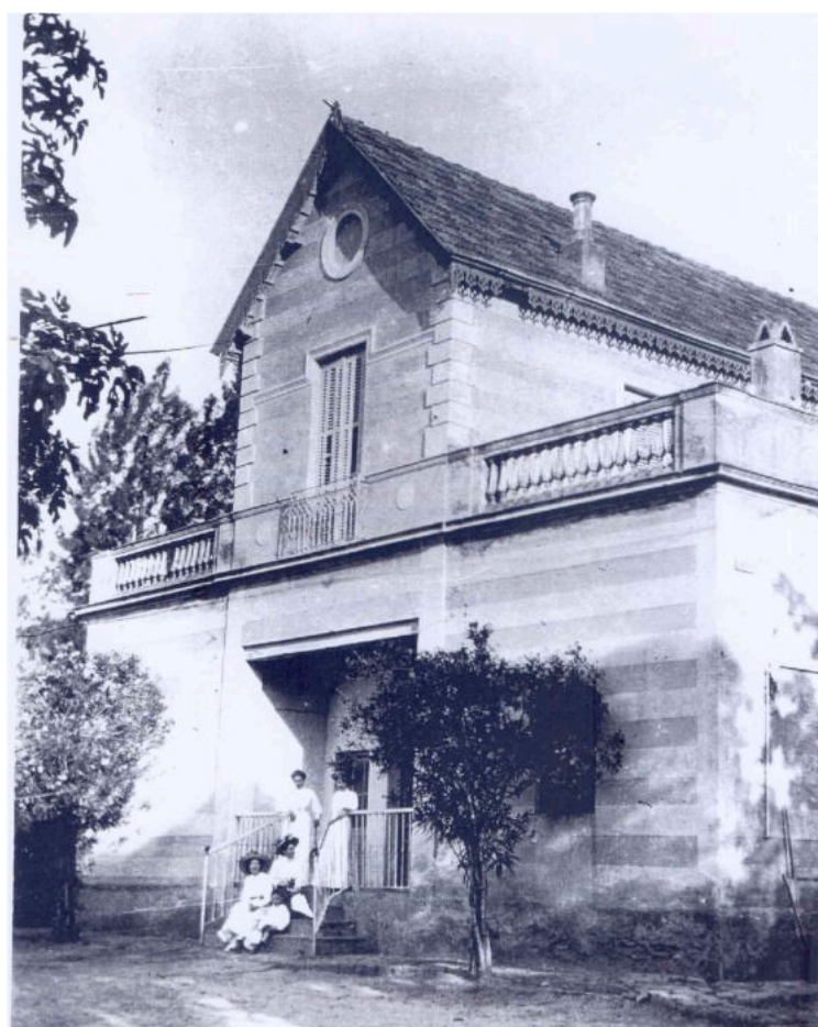
Fig. N°227: Vista desde la esquina de Pringles y Videla
