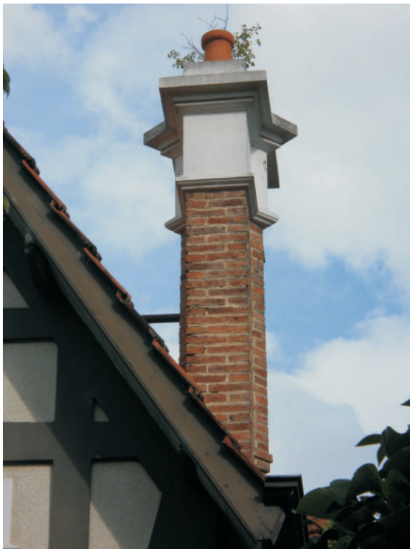
Fig.N°197: Chimenea terminada con roughcast render , S. de Oro y Rivadavia, Temperley. Fig.N°198: Chimenea de ladrillo visto. Fig.N°199: Conducto de ladrillo facetado y con moldura superior, Gral. Paz N°111, Temperley. Fig.N°200: Conductos adosados, Esquina de J.C.Paz y Suárez, Temperley. Fig.N°201: Conductos adosados, Av. Fernández N°365, Temperley. Fig.N°202: Chimenea con arcos en relieve, Suárez al 400, Temperley Fig.N°203a: Conducto de ladrillo visto con fajas y molduras enlucidas. Fig.N°203b: Variante de conducto de ladrillo visto con remate enlucido moldurado, Av.Fernández N°164, Temperley.
