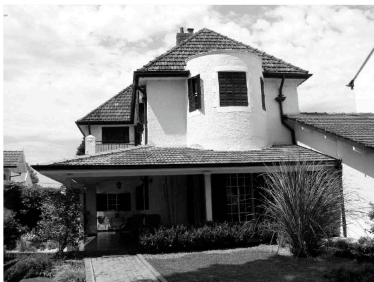
Fig. N°203: Vista del frente en su estado actual
