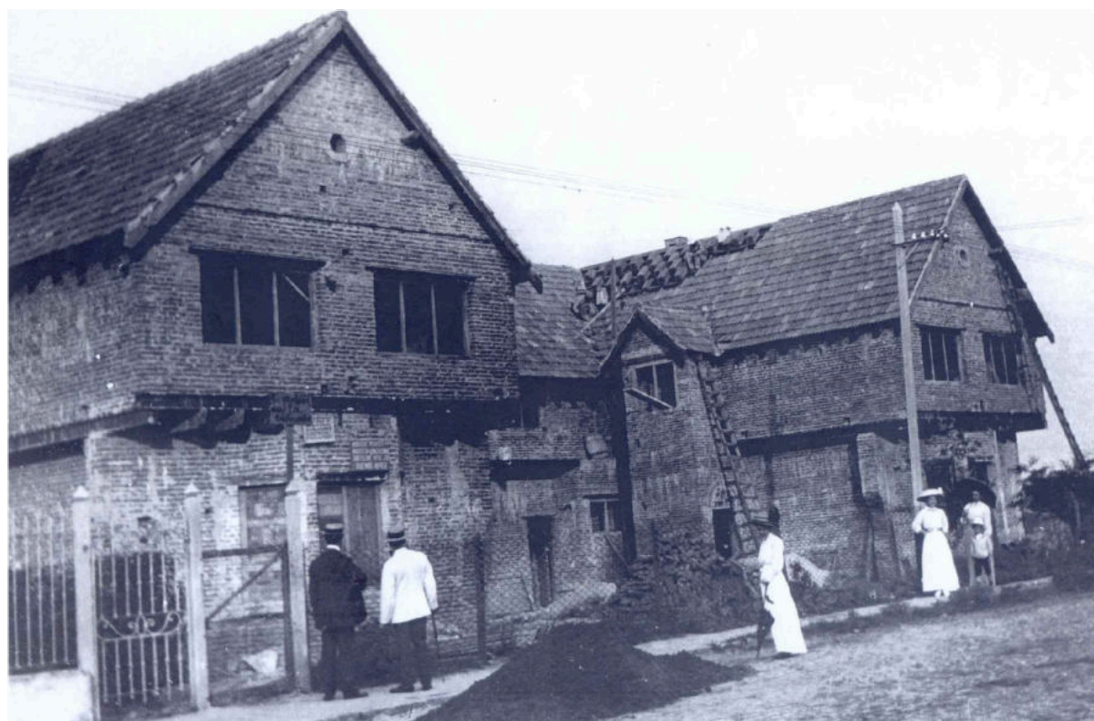
Fig. N°270: Planta baja y planta alta Fig. N°271: Obra en proceso de construcción, circa 1912
