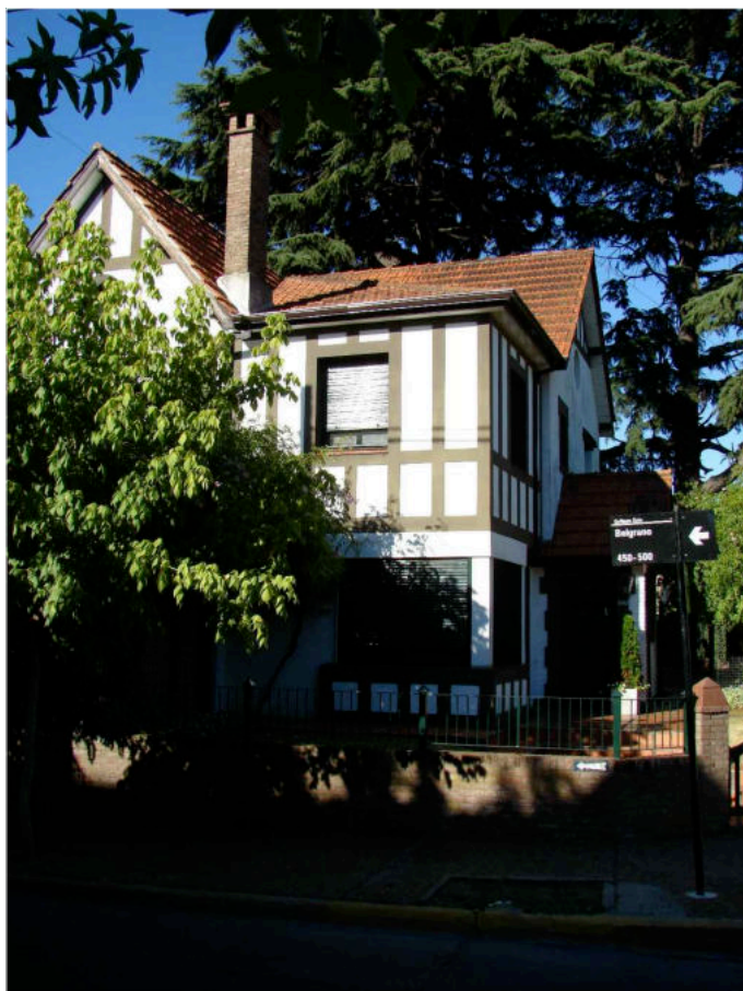
Fig. N°223: Vista parcial desde calle Belgrano Fig. N°224: Vista parcial del volumen con pan de bois sobre calle Belgrano.
