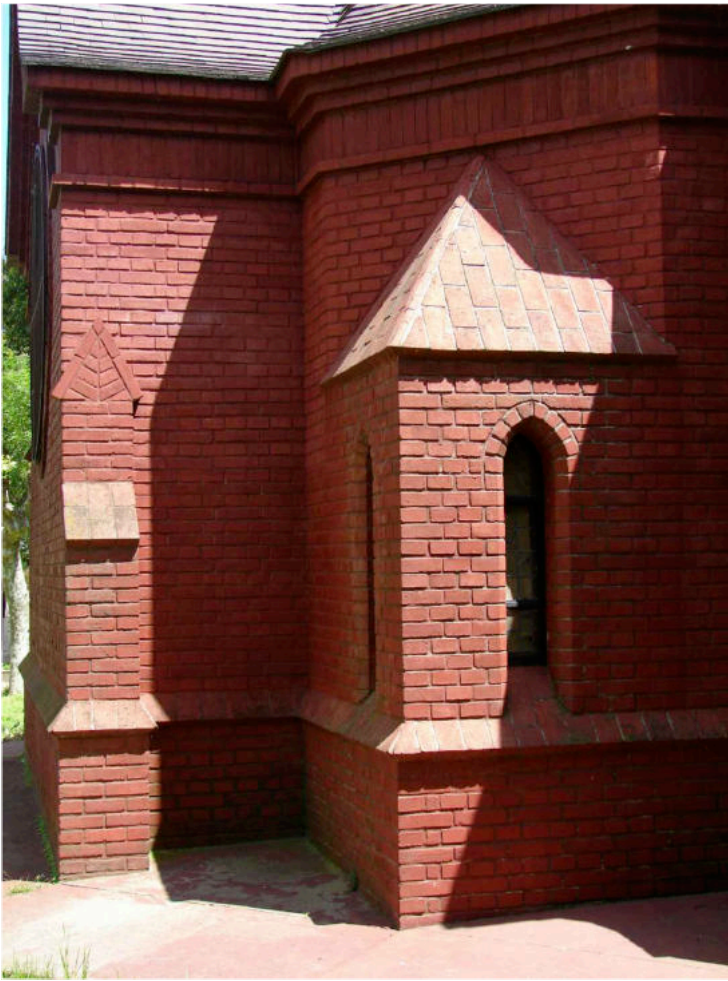
Fig. N°44: Cuerpo de sección triangular adosado al muro dispuesto a 45° Fig. N°45: Vista interior, solado de baldosas negras con guardas blancas Fig. N°46: Detalle de uno de los ángulos abovedados
