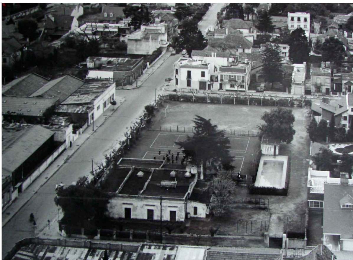
Fig. N°84: Vista aérea del patio con las aulas antiguas de madera y la casa que fuera de John Davidson. Fig. N°85: Vista aérea de La Ynes con parte del campo de deportes hacia la década de 1960
