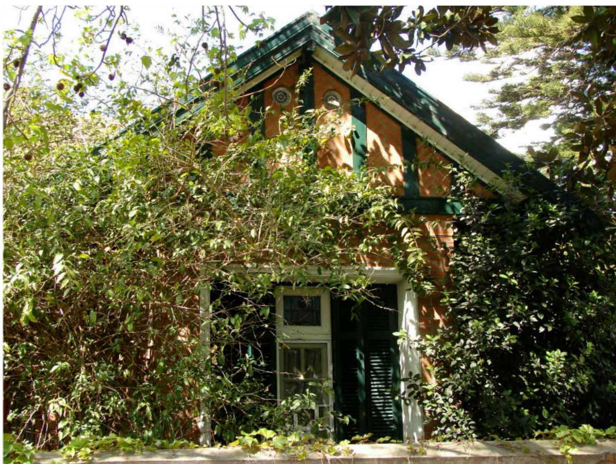
Fig. N°191: Vista parcial de la galería noroeste Fig. N°192: Vista del volumen con pan de bois
