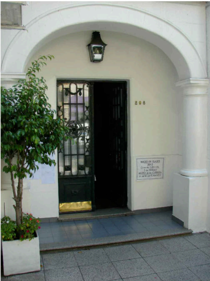
Fig. N°233: Vista del frente sobre calle Alvear Fig. N°234: Porche de acceso
