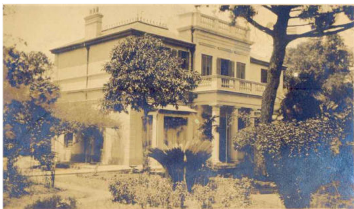
Fig. N°90: Antigua casa de S. Kier, sede del Cricklewood .
