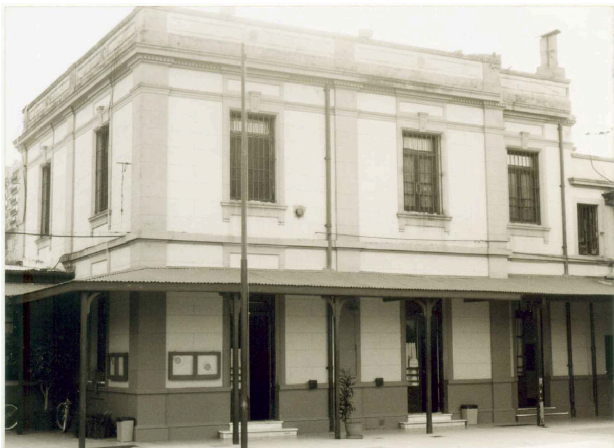
Fig. N°142: Vista parcial de la fachada actual Fig. N°143: Vista noreste desde el patio con la galería agregada Fig. N°144: Vista de una de las ventanas de la fachada Fig. N°145: Detalle de balcón
