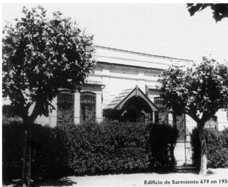
Fig. N°181: Planta Fig. N°182: Vista del frente cuando era sede del Colegio E.Holmberg, fotografía 1956.
