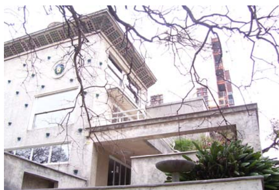
Fachada sobre calles Domingo Cullen.
