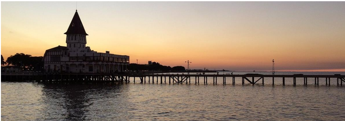
COSTANERA NORTE. Capital Federal de Buenos Aires.
