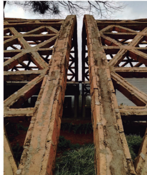
-Los Nervios de cemento y hierro en la bóveda tiene una sección mas ancha para estabilizar la estructura.
