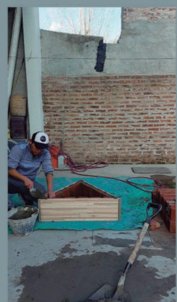
-Terminación del llenado de junta:
