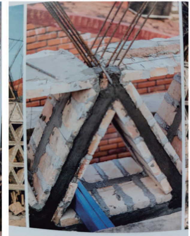
-Forma de parejo del triangulo, con mortero de cemento y refuerzos de hierro de construccion.
