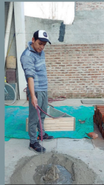
-Elaboración del mortero de cemento 1/3 y 1/2:
