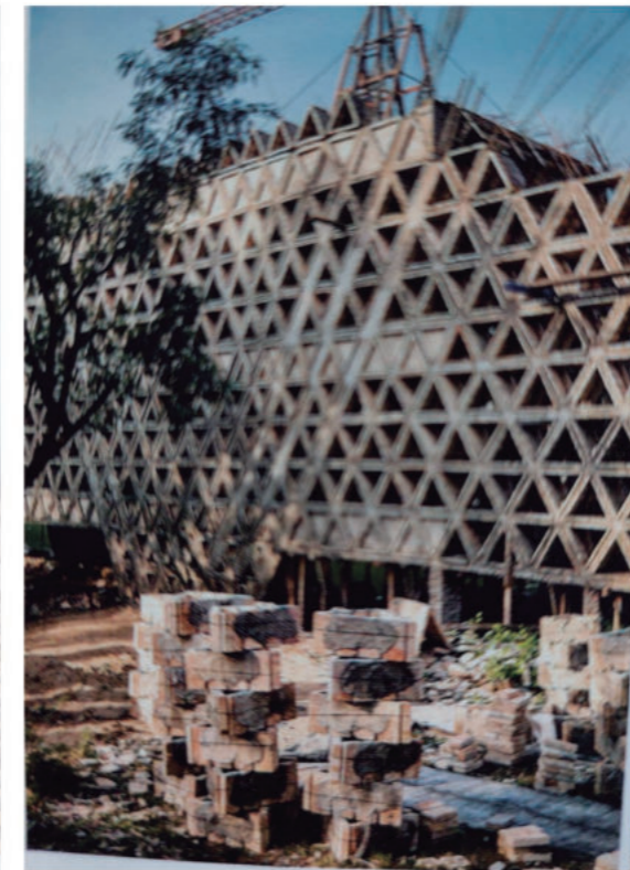
-Forma de apilamiento del triangulo de ladrillo pre-fabricado en obra.
