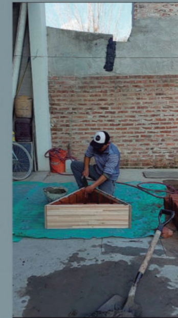
-Rellenado de la junta de mortero 1°:
