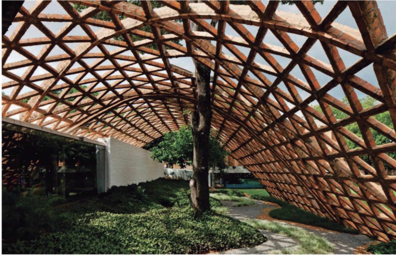
-El Pabellón de ladrillo, de Solano Benítez crea un sistema constructivo a partir del empleo de triángulos de ladrillo pre-fabricados, formado una estructura laminar aligerada que trabaja principal mente a compresión.
