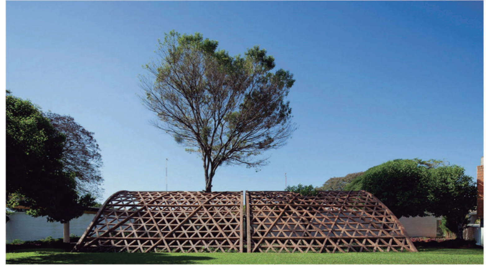
-Esta estructura necesita refuerzos horizontales, diagonales y en los bordes. Ya que su sección de la bóveda aligera de ladrillo tiene un espesor de 12cm aproximado que es ancho de ladrillo.
