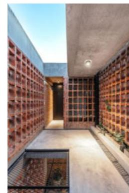
SE OPTA POR UNA DOBLE MATERIALIDAD, POR LA CARA NORESTE UNA FACHADA ESPEJADA PONE EN VALOR LA PREEXISTENCIA DEL PABELLON 6, AL MISMO TIEMPO LA DOBLE PIEL DE VIDRIO FUNCIONA COMO UN MODO DE ACONDICIONAMIENTO TERMICO PASIVO, POR OTRO LADO, LA CARA SUROESTE POSEE UNA FACHADA COMPUESTA POR UNA CELOSIA DE LADRILLO QUE CREA UN TAMIZ DE LUZ, INTEGRA EL EXTERIOR E INTERIOR Y PERMITE EL INGRESO DE AIRE NATURAL AL EDIFICIO.
