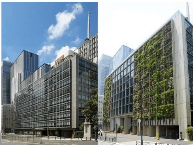
antes y después de la reforma
