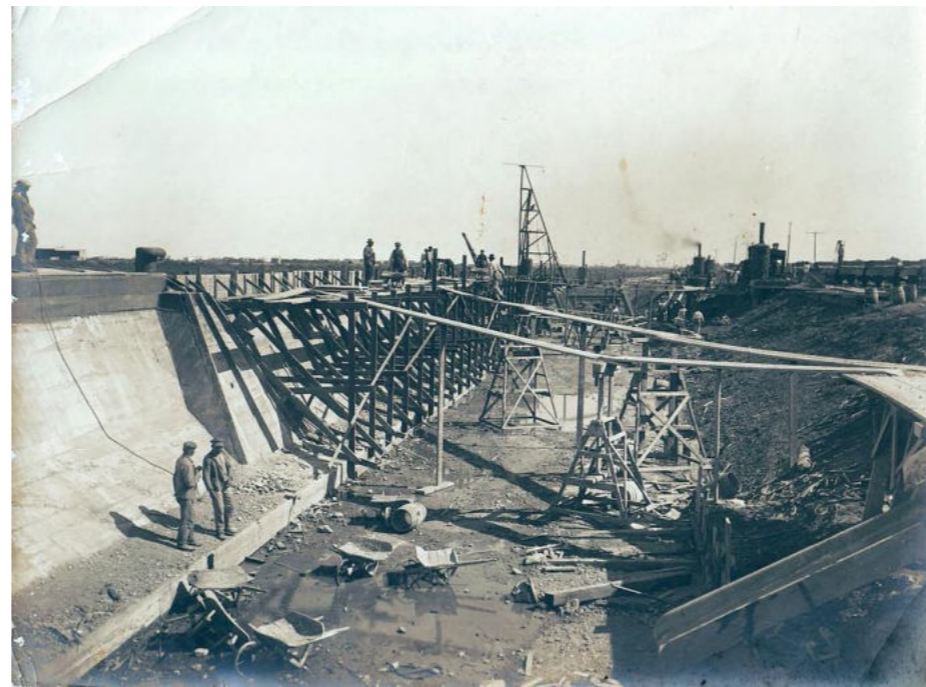
Construcción del puerto de Dock Sud.
