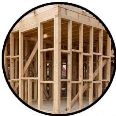
Montaje de paneleria
