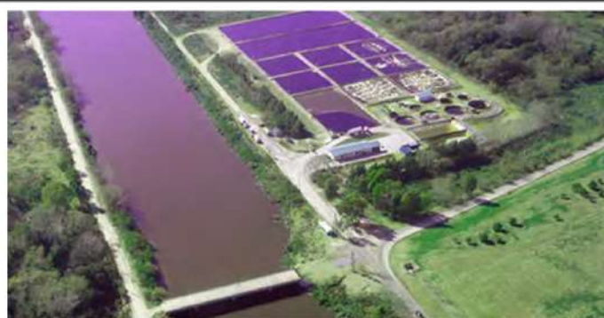
㉑ Planta potabilizadora en zona de humedales
