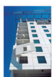
MONTAJE DE PANELES
