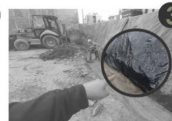
3 Film de polietileno en el talud como protección.
