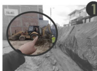
1 Excavación del suelo, dejar rampa de acceso.
