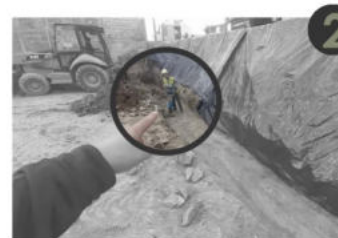
2 Compactación debajo del muro de contención.
