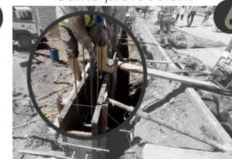
6 Al momento de hormigonar hay que utilizar vibradores , es muy importante para compactar el hormigón .
