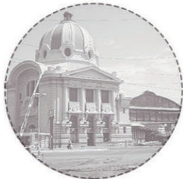
1- ESTACIÓN DE LP
