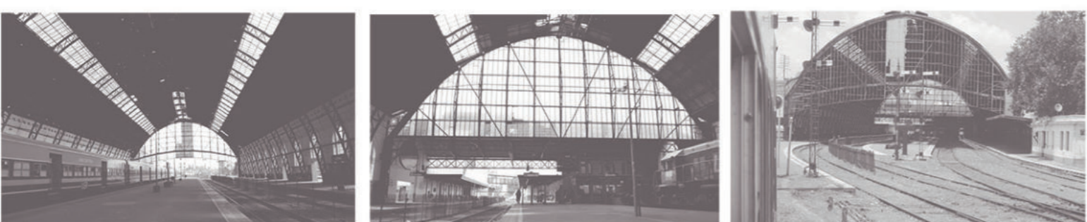
Cubierta antes de la restauración
