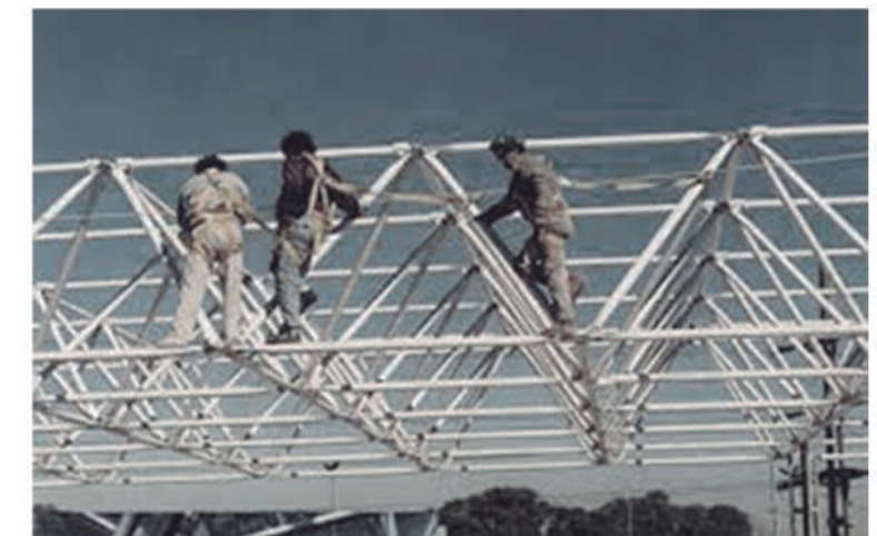
Montaje con operarios trabajando
