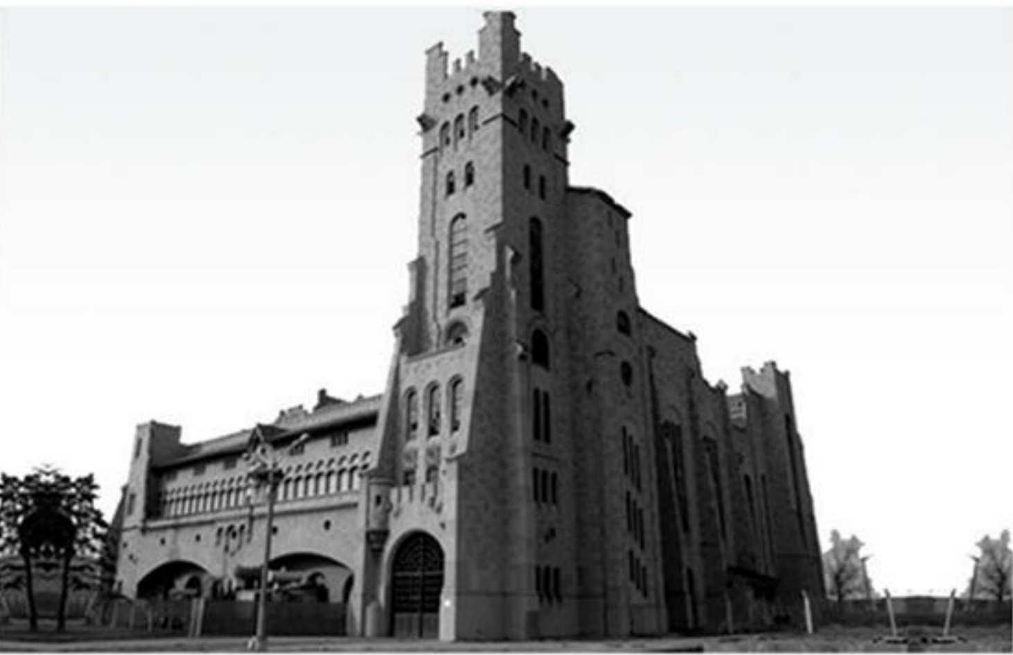
Usina General San Martin Arq. G. Molinari Sitio: Bahía Blanca Uso Anterior: Usina Eléctrica Construcción: 1932 Uso Actual: Abandonada
