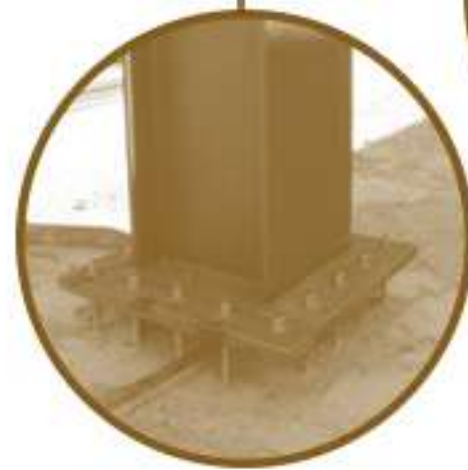
ANCLAJE DE COLUMNAS A FUNDACIONES
