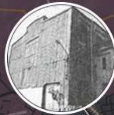
USINA VIEJA GALPON DE MOTORES
