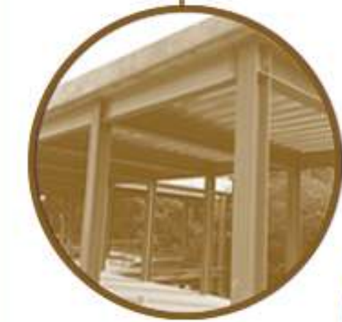
LOSAS PREFABRICADAS DE HORMIGÓN
