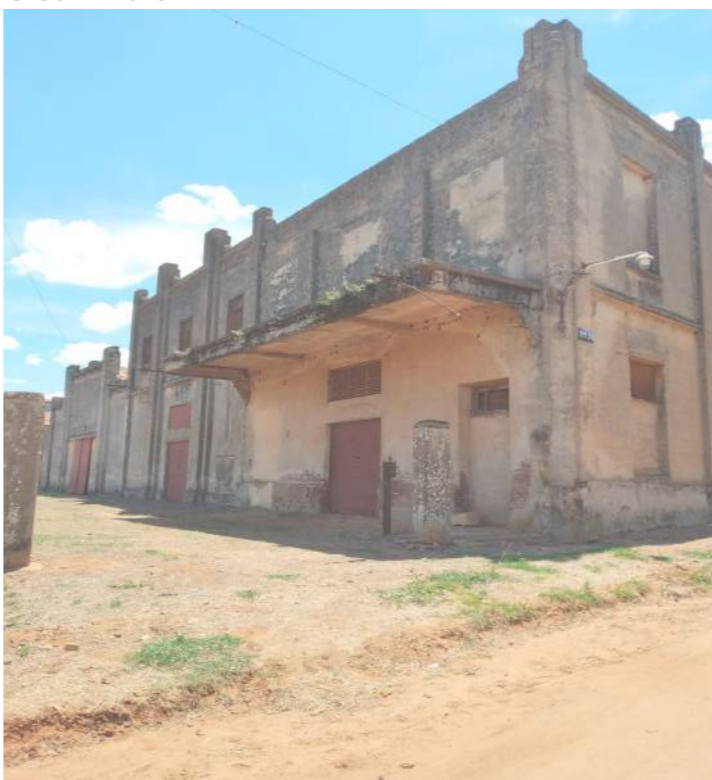
03. Fachada esquina Pellegrini y Placido Martinez
