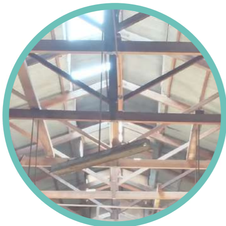
Cabreadas metálicas conformadas por perfiles anudadas a través de planchuelas metálicas.
