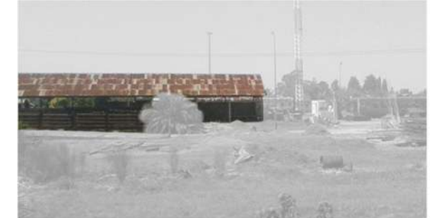
Galpones tinglado - sin envolvente. Uso como deposito.
