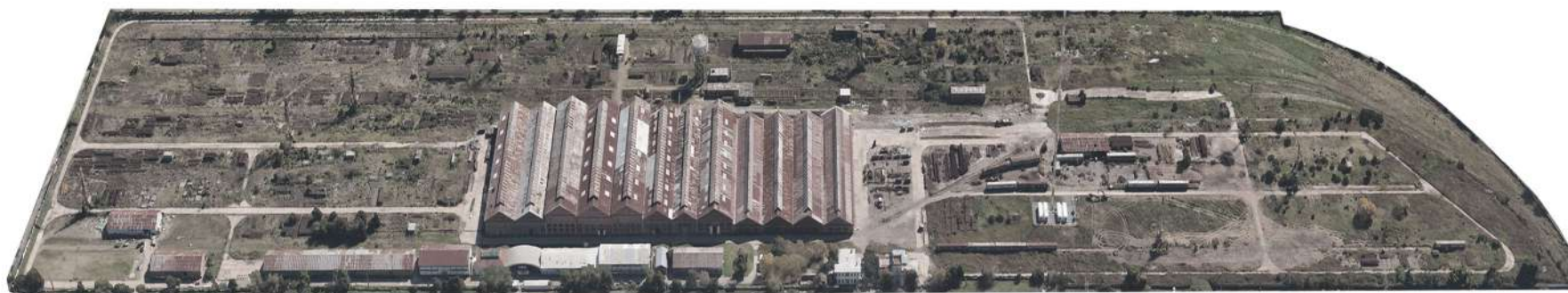
Vista aerea del predio en la actualidad.
