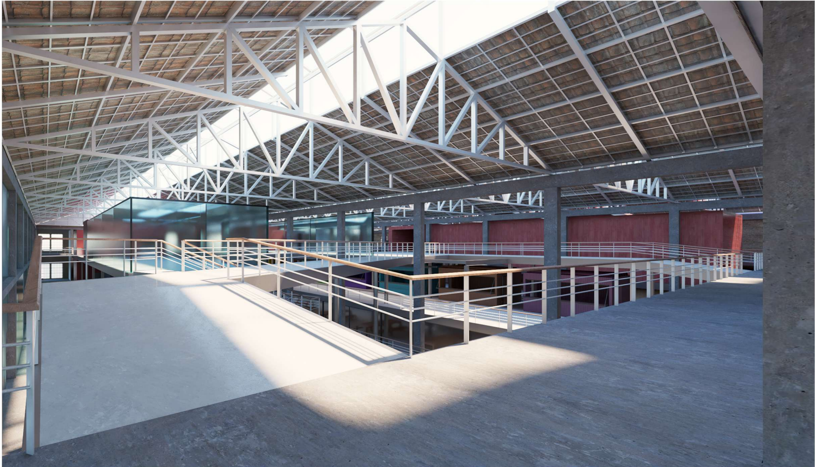
PUENTE PEATONAL DERECHO
