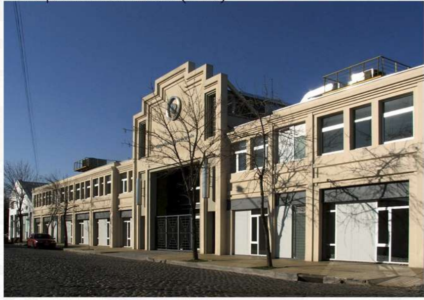
Nueva obra del edificio del ex Mercado de Pescado / Centro Metropolitano de Diseño (CMD)
