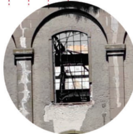
LAS FACHADAS CON REVOQUE SÍMIL PIEDRA Y MODULADA CON AROS QUE CONTIENEN LOS VENTANALES
