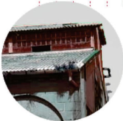
CUBIERTA DE CHAPA DE FIBROCEMENTO. LUCARNA LONGITUDINAL DE LA PREEXISTENCIA.
