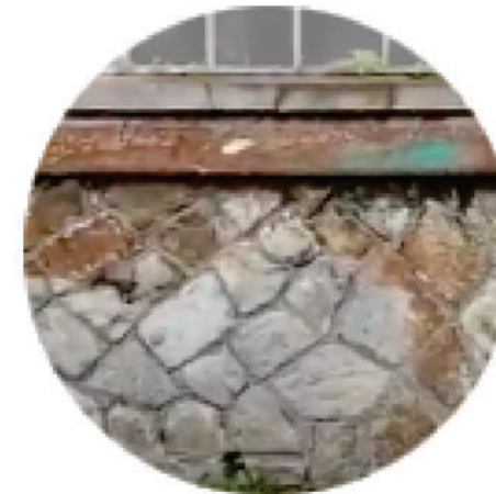
PRESENTAN UN ZÓCALO DE PIEDRA EN TODO EL PERÍMETRO.
