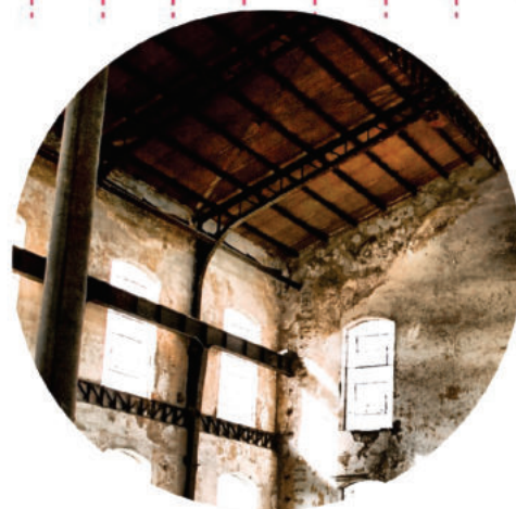
ESTRUCTURAS CON PÓRTICOS INDEPENDIENTES Y CABIADAS METÁLICAS
