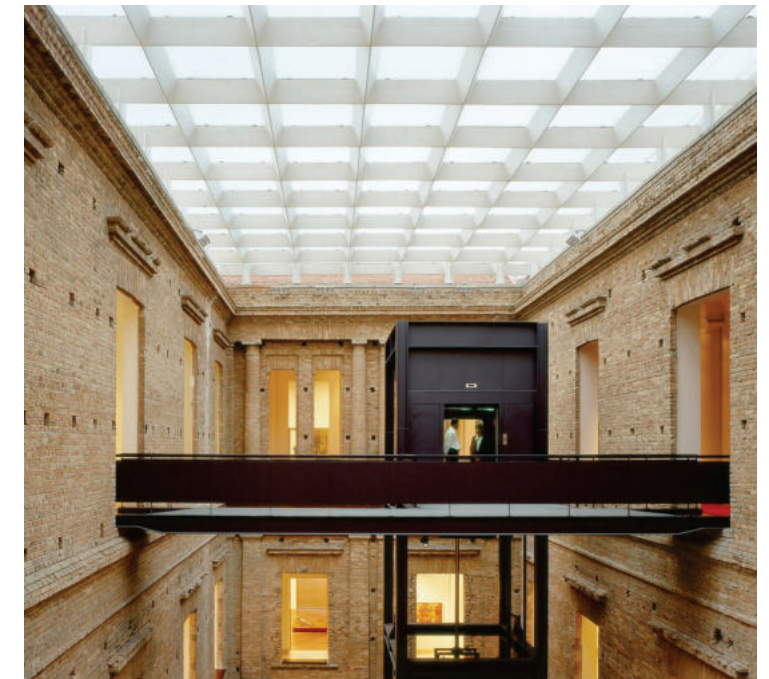
PINACOTECA DEL ESTADO DE SÃO PAULO (DA ROCHA + COLONELLI + RICO Y TORRES)
