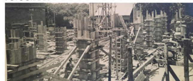
CONSTRUCCIÓN DE COLUMNAS DE H°A°
