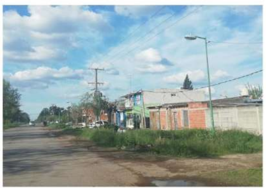
VIVIENDAS SOBRE CALLE 154 ESTRUCTURA HªAº + LADRILLO HUECO
