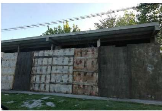
LOSA ALIVIANADA Y ESTRUCTURA DE HORMIGÓN
