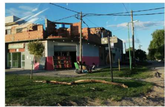
COMPLETAMIENTO DE VIVIENDA EN ETAPAS
