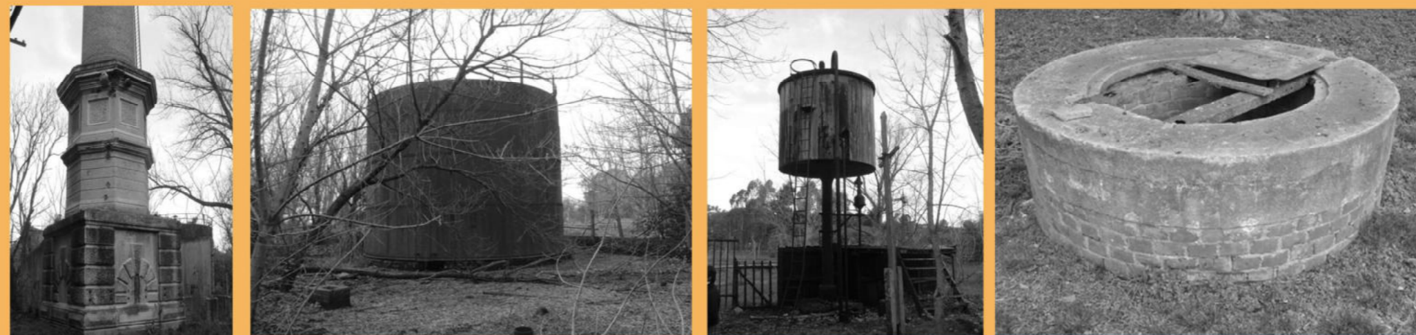
AMIENTO COMPLEMENTARIO: CHIMENEA, TANQUES, POZOS- ESTADO ACTUAL
