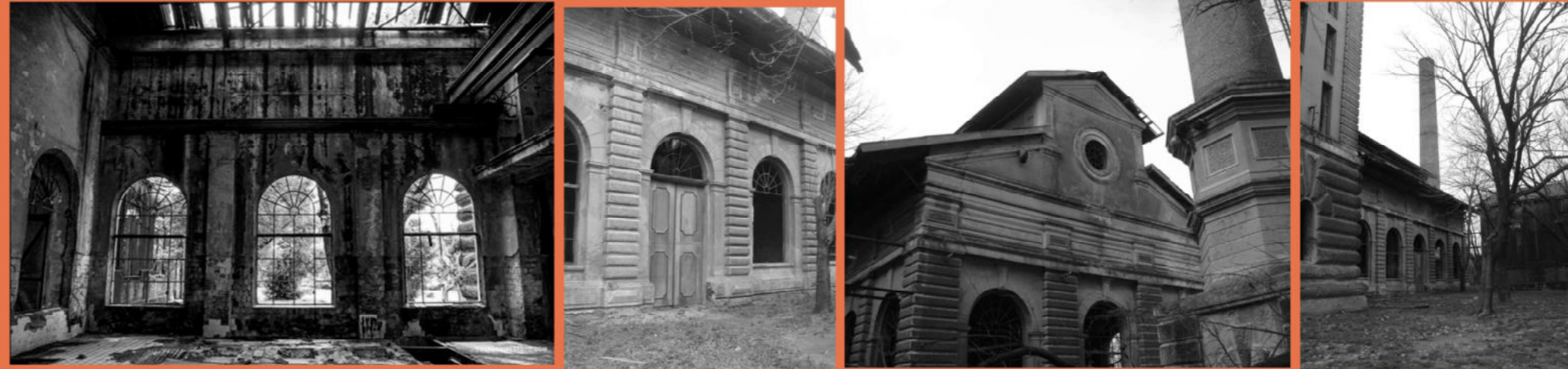
EDIFICIO DE SALA DE MAQUINAS- ESTADO ACTUAL
