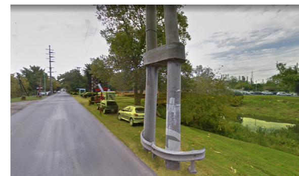
4- Vista desde la calle 129 hacia el cruce de vías a través del canal Rodríguez .
