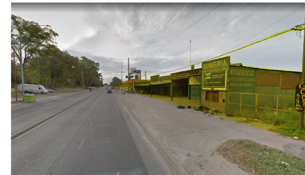
5- Vista desde Av 122 donde se genera una grieta en días de actividad el tráfico la falta de conexión lo vuelven un riesgo.
