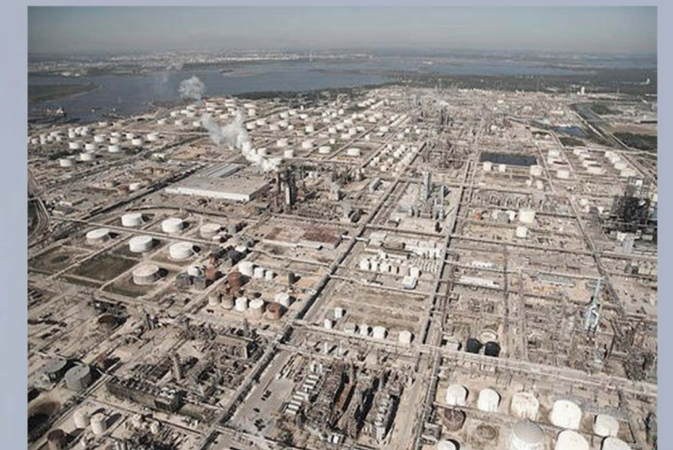
Refinería de BayTown - EEUU
