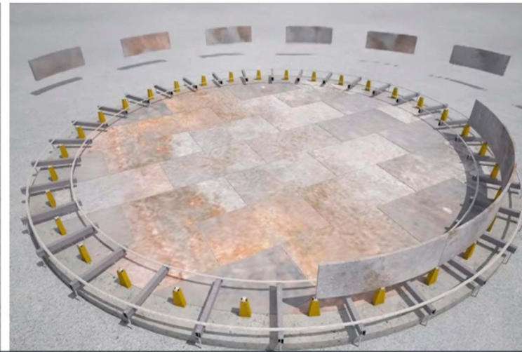
3- Colocación de placas metalicas del anillo
