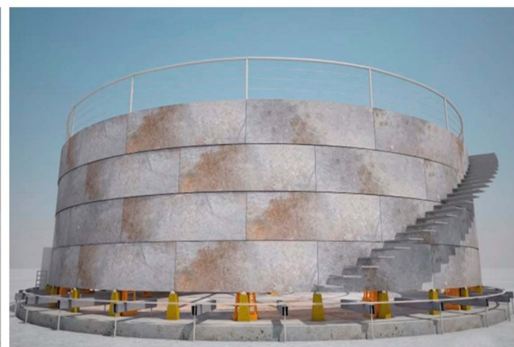
11- Montaje y elevación de los siguientes anillos del tanque
