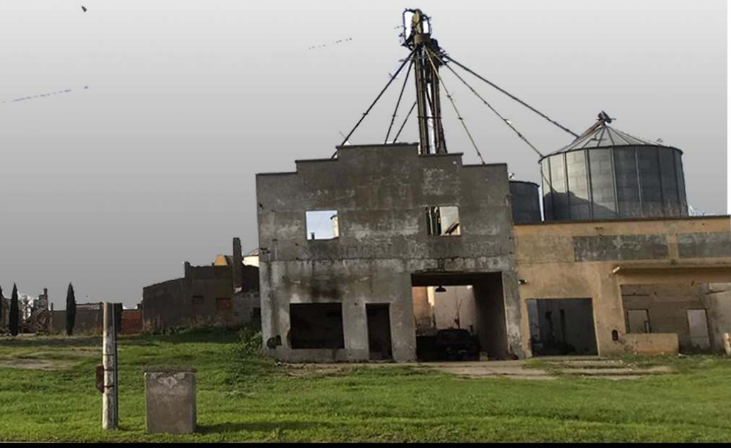
Vista de la totalidad de las construcciones desde el Río
