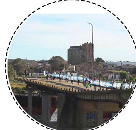
7 Protesta de los vecinos por la reconstrucción del puente.
