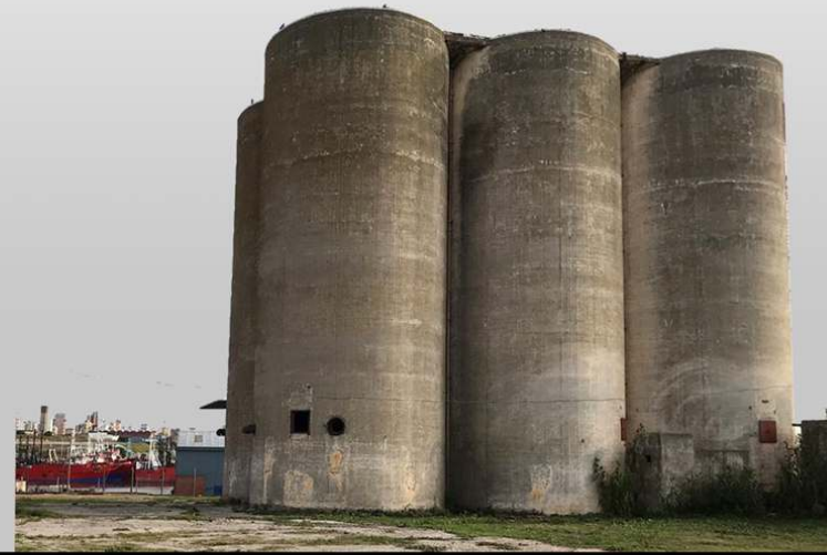
Silos de Hormigón vista desde ciudad
