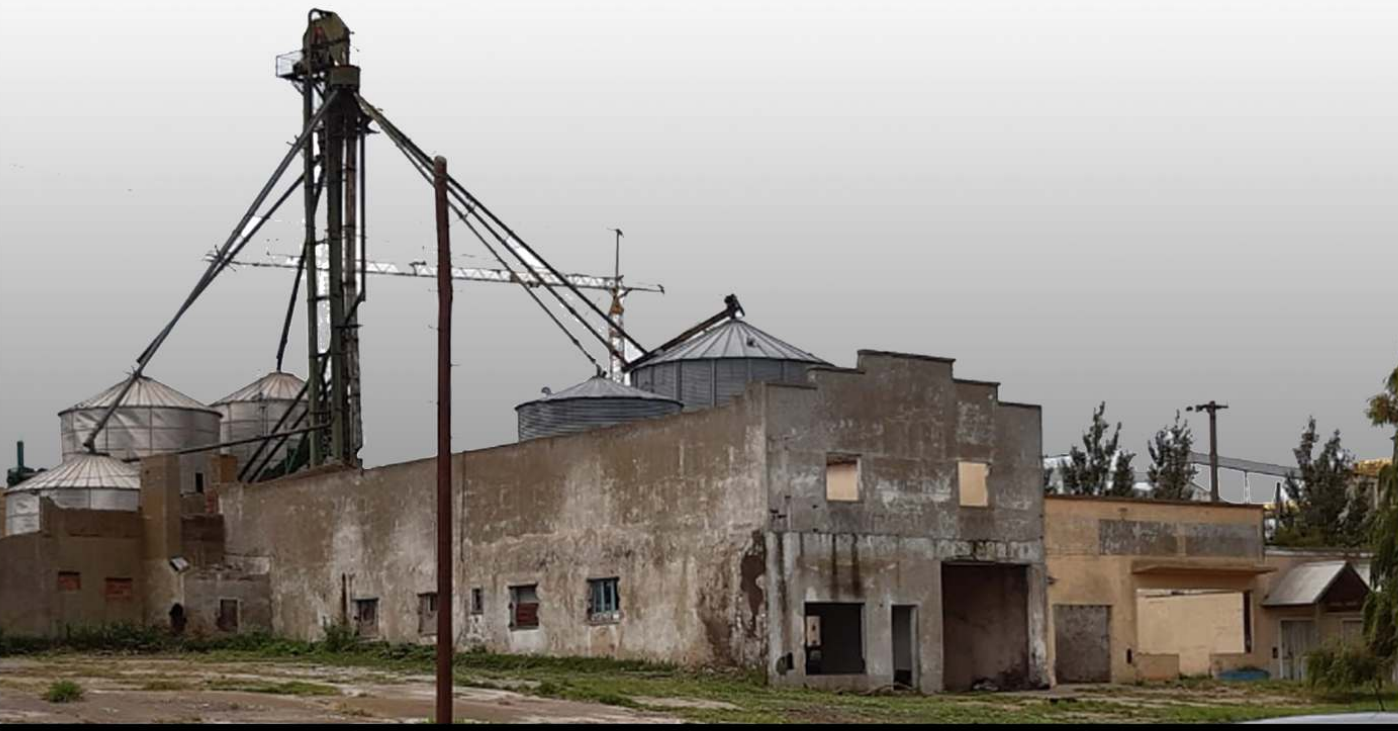
Fábrica desde el Río, de fondo silos metálicos
