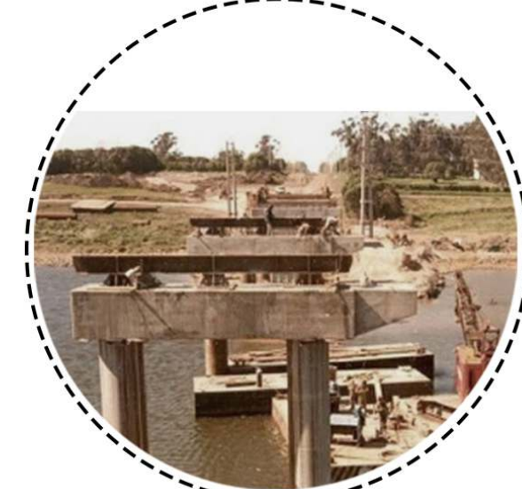
6 Construcción del puente Dardo Rocha
