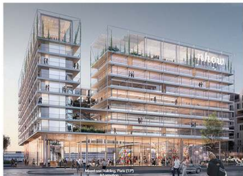
Mixed-use Building - Chartier Dalix Architectes París, Francia
