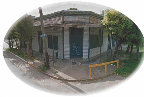
CONSTRUCCIONES DE CHAPA
