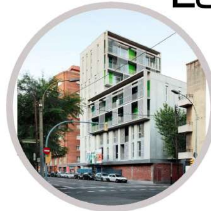
Viviendas en Les Corts Barcelona FLEXO ARQUITECTURA
