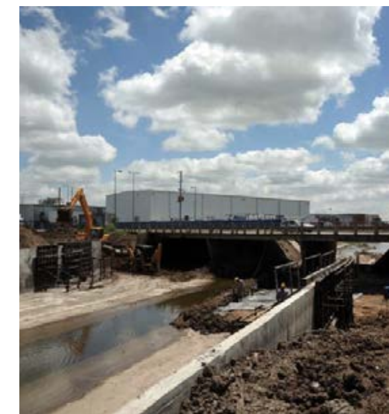
Obra sobre intersección Avenida 19 y 520
